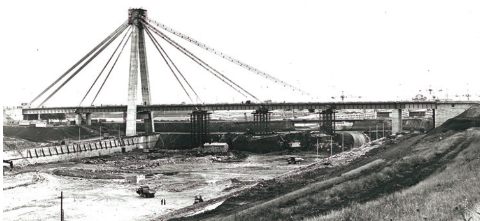
Fig. 24 - Aspect din execuție. Suporti provizorii la montaj
