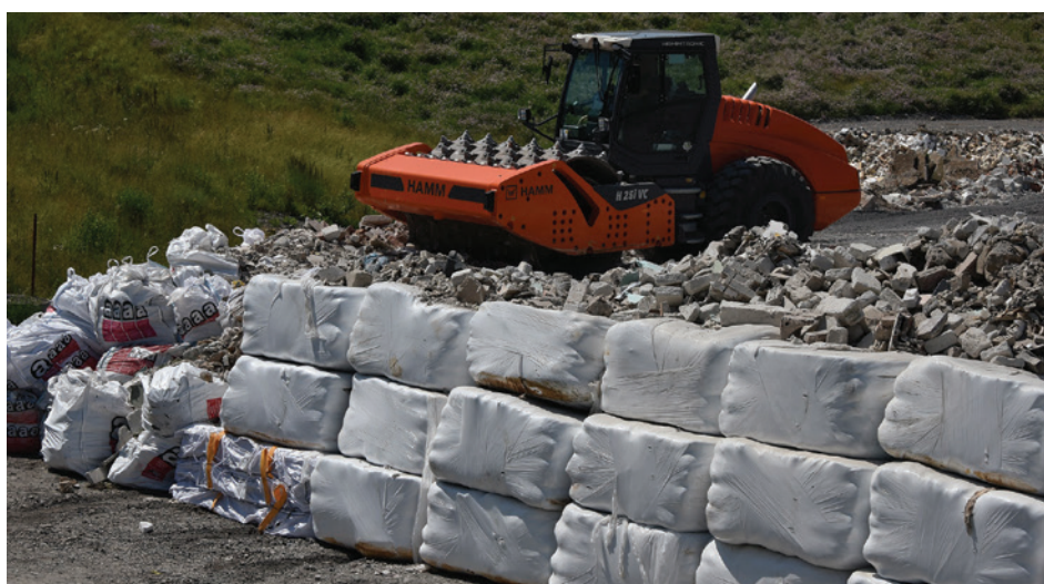
Foto 2 - La depozitul Steinmühle, compactorul H 25i VC de la Hamm compactează straturile de deșeuri de construcții și cenușă care sunt distribuite peste deșeurile contaminate. Materialul de compactat vine ambalat și este aranjat în straturi aprox. 2 m înălțime.
