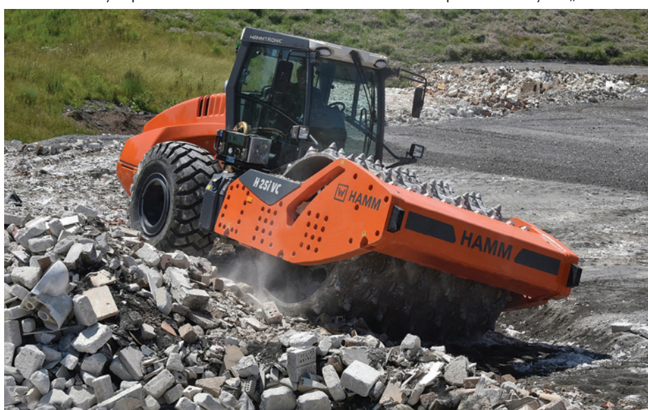
Foto 1 - Greutatea mare a compactorului de concasare H 25i VC și tamburul vibrant produc sarcini punctuale de până la 50 t sub fiecare picon de zdrobire. Sub această sarcină, deșeurile minerale sunt zdrobite instantaneu.
