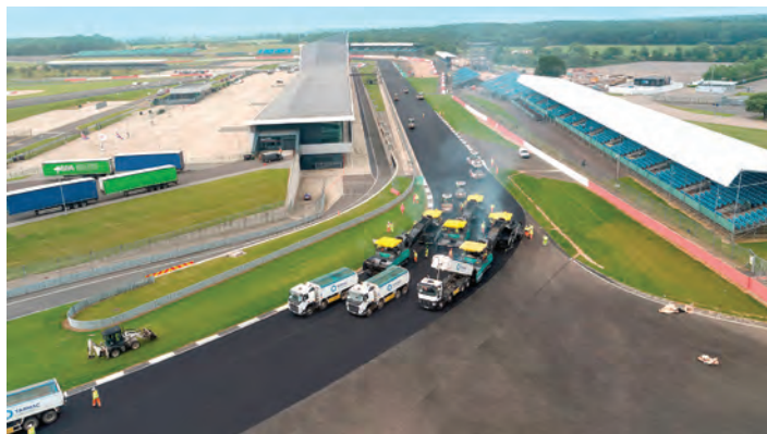
Foto 5 - 360 t/h de asfalt turnat: Un rezultat grozav pentru cele trei finisoare de asfalt Vögele SUPER 1800-3i, lucrând în combinație cu alimentatoarele Vögele MT 3000-2i Offset. La acest rezultat a contribuit și un lanț logistic impecabil: o flotă de 12 autobasculante cu temperatură controlată, la o cadență inteligentă.
