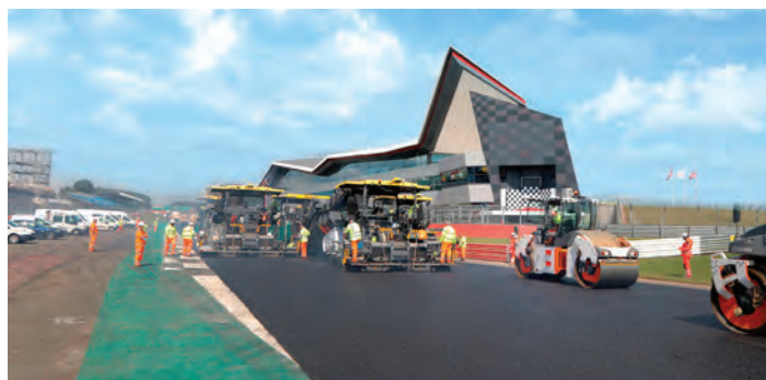
Foto 4 - Ulterior, mașinile Vögele au turnat un nou strat de uzură. Finisoarele de asfalt SUPER 1800-3i au convertit automat parametrii 3D recepționați. Utilizarea alimentatoarelor a eliminat transferul de material de la basculante la finisoare.
