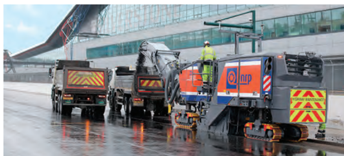
Foto 3 - Frezare 3D: Marile mașini de frezat W 210 Fi au pregătit fundația ideală pentru noul profil al pistei.
