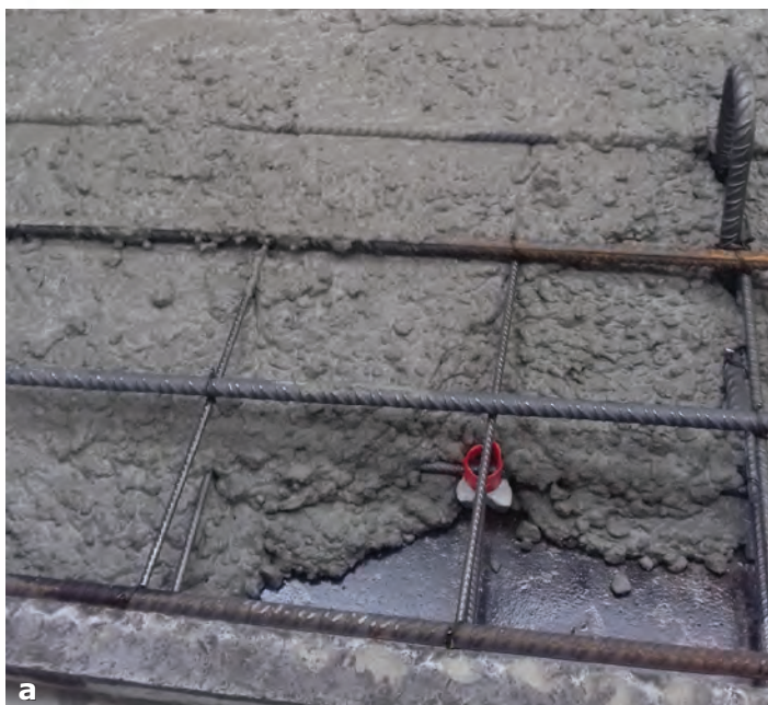
Fig. 2 a, b – În conformitate cu noile reglementări tehnice, grosimea de beton nominală („ c_{nom} ”) a armăturilor elementelor prefabricate se calculează pentru toate tipurile de armături înglobate și se raportează la armătura cea mai apropiată de suprafață
