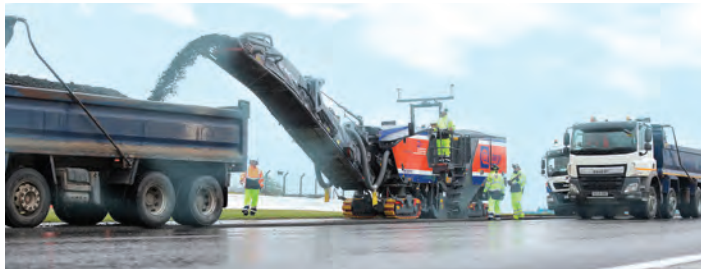
Foto 2 - Mașinile de frezat la rece Wirtgen au primit prin intermediul unui receptor laser, de la un tahimetru electronic, date despre adâncimea de frezare și au frezat exact diferența necesară dintre suprafața pistei și noul profil necesar, în fiecare punct.
