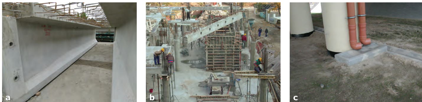
Fig. 1 a, b, c – Diferite elemente prefabricate cu durate de viață stabilite prin Eurocod 0 (CR 0 / 20212). În stânga o grindă de pod cu durată de viață de minim 100 de ani, în centru o grindă pentru o clădire civilă având o durată de viață de 50...100 de ani iar în dreapta elemente de rigolă cu durată de viață de până la 10 ani.
