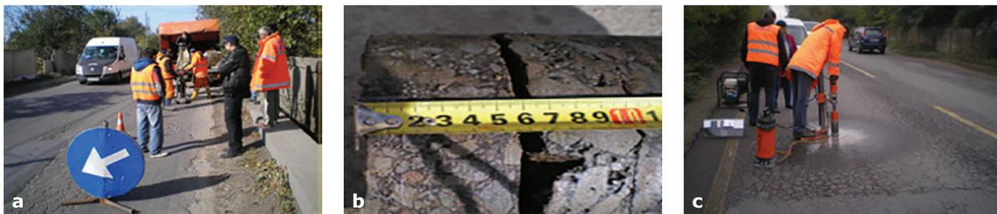
**Fig. 9 a, b, c - Asigurarea suprafeței de lucru și efectuarea de carotări**
