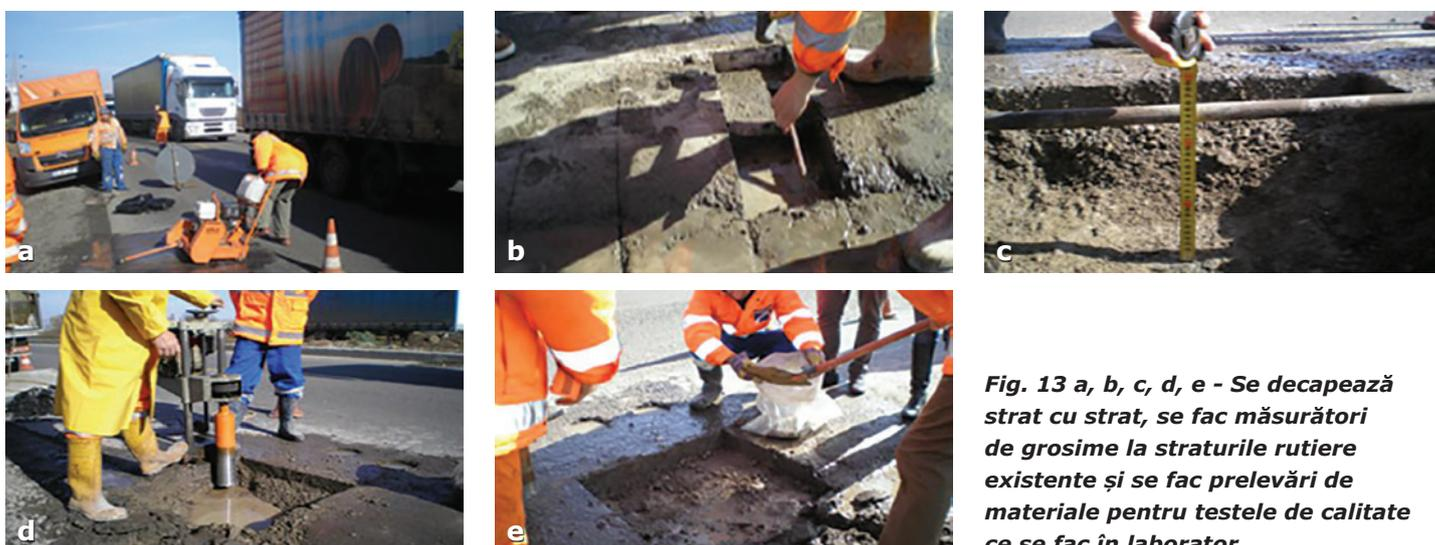
**Fig. 13 a, b, c, d, e - Se decapează strat cu strat, se fac măsurători de grosime la straturile rutiere existente și se fac prelevări de materiale pentru testele de calitate ce se fac în laborator**
