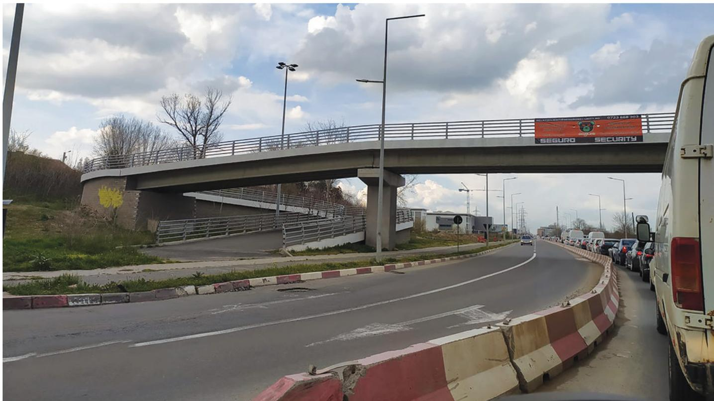
**Fig. 3,4,5 – Pasaj Năvodari – executat cu Sistemul Tensar TW1 (2016)**
