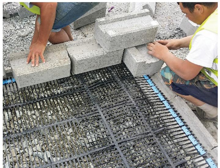
Fig. 1,2 – Instalare simplă, manuală, fără macarale sau sprijiniri
