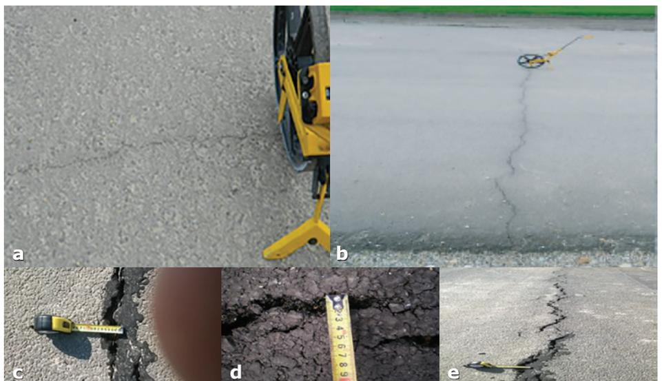
**Fig. 3 a, b, c, d, e - Identificarea prin măsurători a suprafețelor fisurate și cu crăpături longitudinale**
