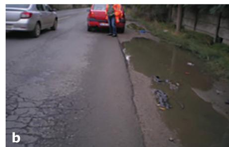
Fig. 4 - a. Faianțări cu grad de severitate ridicat (AND540). b. Lipsă sistem de colectare-evacuare ape pluviale, cu bălțirea pe acostamente
