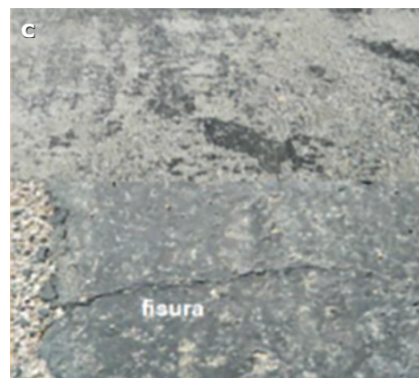
Fig. 3 a,b,c - Fisurare la nivelul stratului de bază din balast stabilizat, unde au apărut fisuri din variații de temperatură, chiar dacă s-a aplicat amorsa protectivă din emulsie bituminoasă
