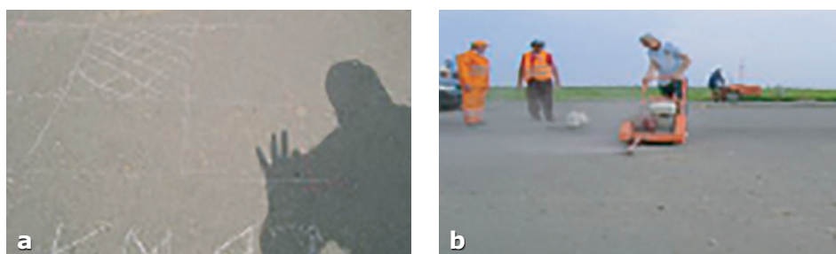
Fig. 8 a,b - Pentru a nu deranja structura straturilor rutiere din alcătuirea unui sistem rutier rigid, se procedează pentru sondajul deschis de structură rutieră la tăierea pe suprafețe mici cu mașina de tăiat rosturi
