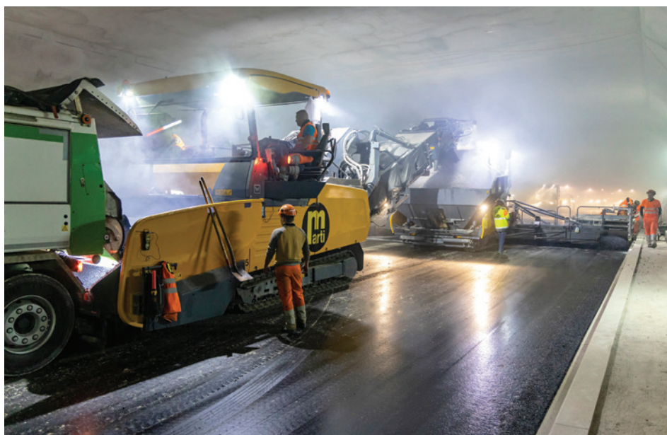
Foto 4 - O combinație de mașini de înaltă performanță: alimentatorul offset VÖGELE MT 3000-2i, finisorul de asfalt SUPER 2100-3i și șapa fixă SB 300 au realizat o planeitate perfectă a suprafeței asfaltate, chiar și pe o lățime de 11,50 m.
