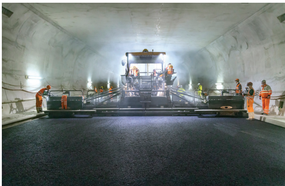
Foto 1 – Lucrări de asfaltare în cel mai larg tunel din Elveția: proiect de anvergură finalizat cu succes grație utilizării mașinilor VÖGELE și soluției software de optimizare a proceselor WITOS Paving Plus, de la același producător
