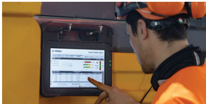
Foto 3 - Modulul „Șantier” al sistemului WITOS Paving Plus stabilește ritmul de lucru: echipa de asfaltare a avut o imagine de ansamblu în timp real a progresului lucrării, performanței turnării, precum și a livrării mixturii asfaltice, toate pe o tabletă PC, așa că a putut reacționa rapid în caz de nevoie.
