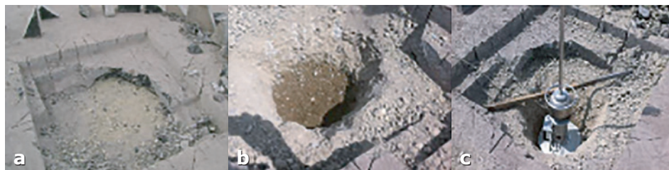
Fig. 7 a,b,c - Prelevarea probelor de laborator din toate straturile din alcătuirea structurii rutiere expertizate, pentru testele ulterioare de laborator
