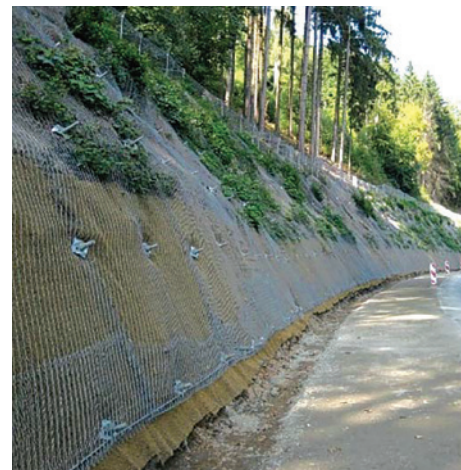
Foto 2 - Stabilizare de versant cu plasă din oțel de înaltă rezistență și rețea antierozională
