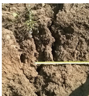
Fig. 16 a, b, c - Măsurători în cazul unor crăpături în platforma drumului
