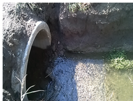
Fig. 14, 15 - Podețe fără canale de dirijare a apei către bazine de retenție
