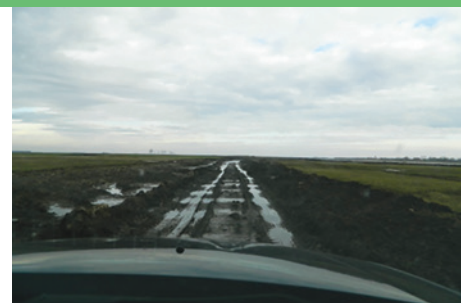
Fig. 1 - Decaparea terenului vegetal și realizarea de șanțuri pentru colectarea și evacuarea apei pluviale
