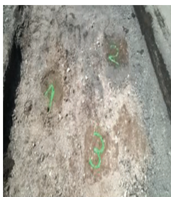
Fig. 18 a, b, c, d - Realizarea măsurătorilor de capacitate portantă la nivelul terenului de fundație al structurii rutiere
