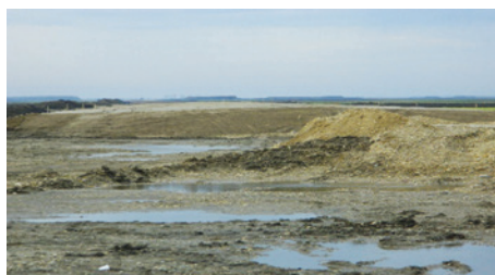
Fig. 10, 11 - Efectele lipsei unui sistem de evacuare a apei pluviale
