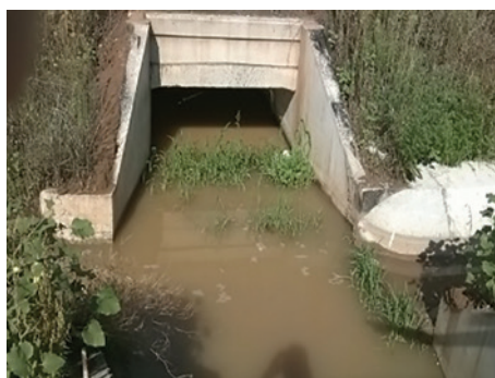
Fig. 14, 15 - Podețe fără canale de dirijare a apei către bazine de retenție
