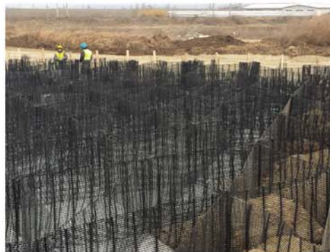
Utilizarea sistemului TensarTech® Stratum® pentru stabilizarea și drenajul bazei unui terasament (Centura Tecuci, România).
