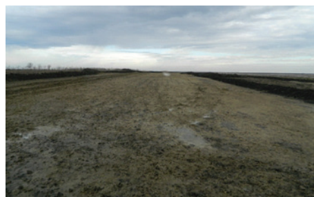
Fig. 4 - Realizarea primului strat de umplutură din corpul terasamentului fără protecție la supraumectare
