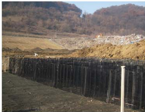
Utilizarea sistemului TensarTech® Stratum® la construirea unui dig la depozitele de deșeuri în condiții de teren foarte moale (Sighișoara, România).
