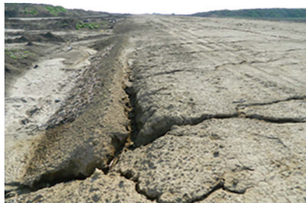
Fig. 7,8 - Ravenări cu grad de severitate ridicat
