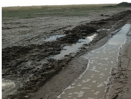
Fig. 12, 13 - Șanțuri provizorii în care apa stagnează
