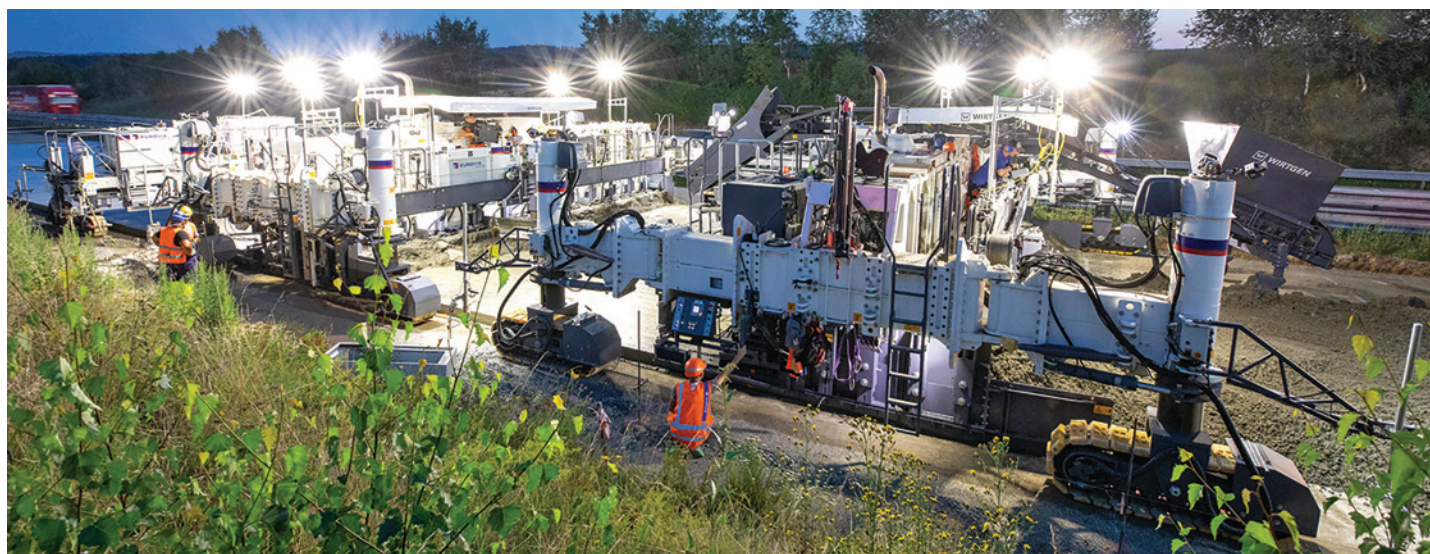
Foto 1 – Două finisoare de beton cu cofraje glisante, SP 154 (i) și o mașină de tratare a suprafeței, TCM 180 (i), au fost utilizate ca tren de pozare a betonului pe o porțiune de 67 km din Autostrada D1, între Brno și Praga.
