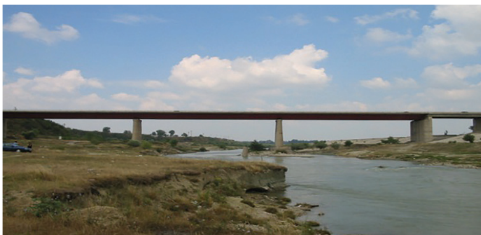
Fig. 9 - Podul peste râul Argeș la Adunații Copăcenii. Vedere generală (Foto: Arhiva personală)
