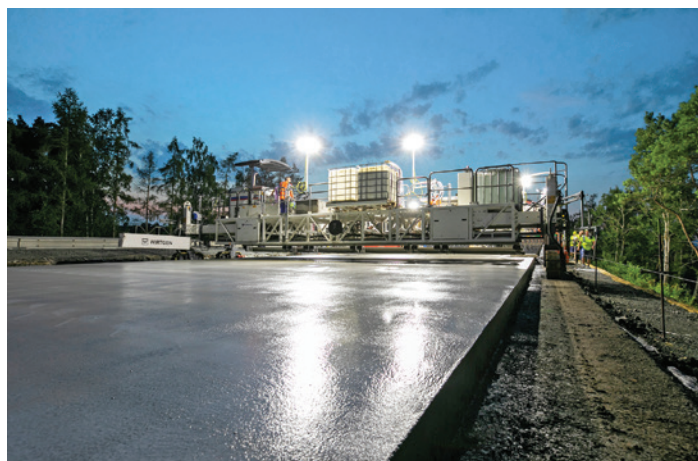
Foto 3 - Mașinile de posttratament Wirtgen, precum TCM 180 (i), sunt responsabile pentru finisarea suprafeței de beton, crearea texturii dorite a suprafeței și pulverizarea unei dispersii pentru a preveni uscarea prea rapidă a suprafeței betonului.
