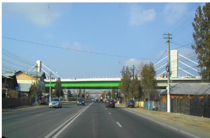
Fig. 12 - Pasajul hobanat Bărcănești. Vedere generală (Foto: Arhiva personală)
