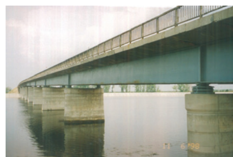
Fig. 7 - Podul nou peste râul Olt la Stoenеști. Vedere generală (Foto: Arhiva personală)
