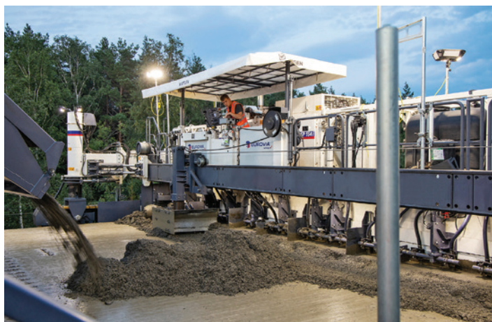
Foto 2 - Betonul stratului superior este transportat de banda rulantă comandată de la distanță, peste finisorul de beton ce pozează stratul inferior și este turnat peste primul strat de beton, în fața finisorului utilizat pentru pozarea celui de-al doilea strat de beton, utilizându-se tehnica „umed pe umed”.
