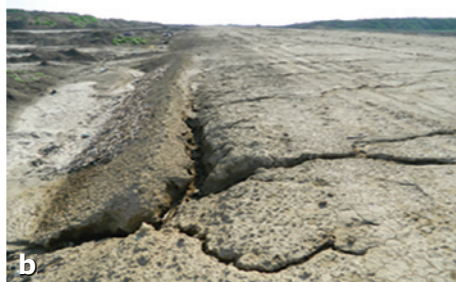
Fig. 9 a, b, c – Degradarea severă a rambleelor realizate din balasturi nisipoase de râu
