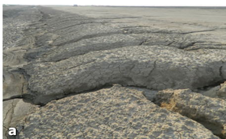
Fig. 9 a, b, c – Degradarea severă a rambleelor realizate din balasturi nisipoase de râu
