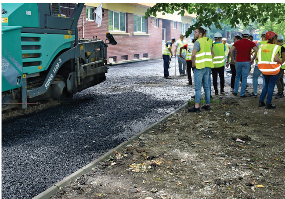
Foto 2 – Participarea studenților la lucrările de asfaltare
