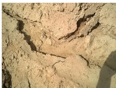
Fig. 6 – Antrenarea hidrodinamică a materialului utilizat în lucrările de terasamente
