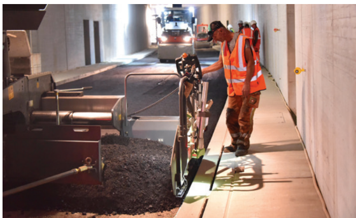
Foto 1 – Compania contractantă a utilizat mașini de la VÖGELE și HAMM pentru a crea o cale carosabilă compactă și de înaltă calitate, în tunelul rutier Karlsruhe.
