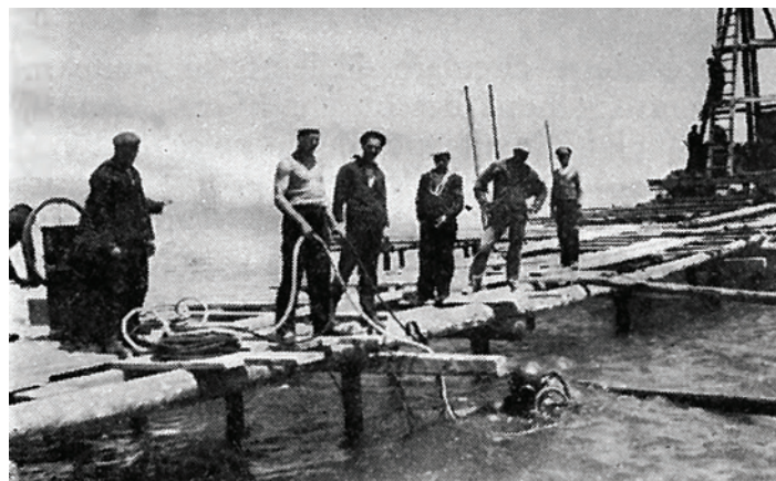
Fig. 7 – Așezarea plăcuțelor și ancorări de fierărie cu ajutorul scafandrierilor marinari
