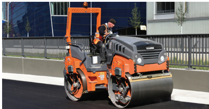
Foto 4 – Pentru compactarea finală a fost utilizat compresorul compact HAMM HD 14i VO cu role tandem, în față cu tambur vibrator și în spate cu tambur oscilant.
