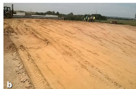
Fig. 7 a, b – Realizarea îmbunătățirii suprafeței prin stabilizare in situ
