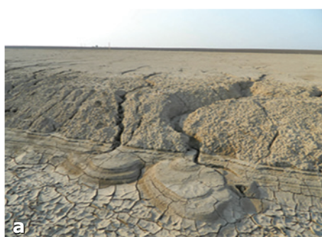
Fig. 8 a, b – Formarea unor ravene în urma scurgerii apei pluviale pe taluz
