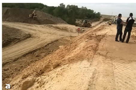
Fig. 7 a, b – Realizarea îmbunătățirii suprafeței prin stabilizare in situ
