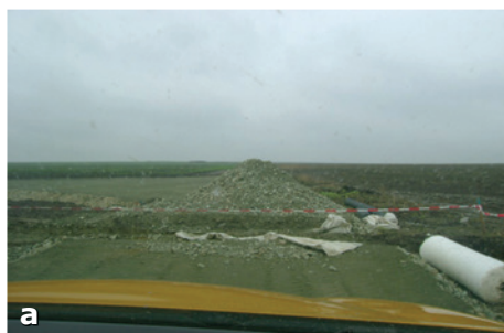
Fig. 14 a, b, c – Argila prăfoasă reține apa pluvială și în cazul asigurării cu materiale geotextile
