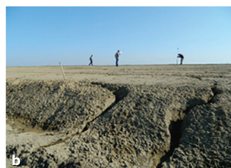
Fig. 8 a, b – Formarea unor ravene în urma scurgerii apei pluviale pe taluz
