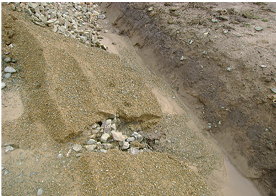
Fig. 15 – Antrenare hidrodinamică a părții fine sub influența apelor pluviale
