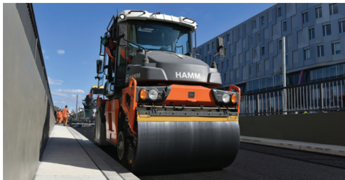
Foto 3 – În special, stratul de bază și stratul de legătură din tunel au fost realizate cu compactorul cu role combinate HAMM DV + 90i VT-S, echipat cu șorturi termice.
