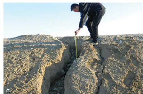
Fig. 9 a, b, c – Degradarea severă a rambleelor realizate din balasturi nisipoase de râu
