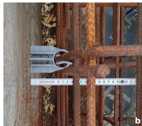
Fig. 2 a, b - În conformitate cu noile reglementări tehnice, grosimea de beton nominală („ c_{nom} ”) a armăturilor se calculează pentru toate tipurile de armături înglobate și se raportează la armătura cea mai apropiată de suprafață pe care se montează distanțierii.
