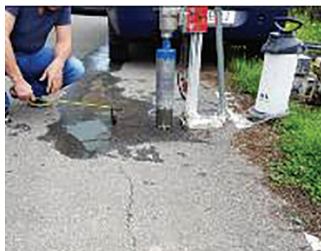
a. prelevarea de carote în zonele afectate ale structurii rutiere
