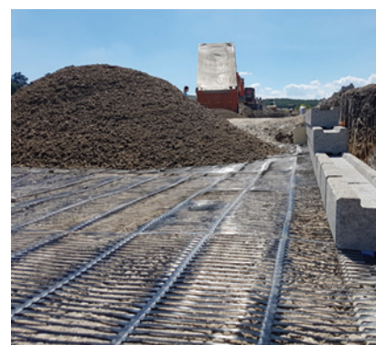
Cofrarea zidului de sprijin din beton versus construcția unui zid de pământ armat
