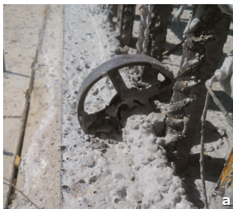
Fig. 2 a, b - În conformitate cu noile reglementări tehnice, grosimea de beton nominală („ c_{nom} ”) a armăturilor se calculează pentru toate tipurile de armături înglobate și se raportează la armătura cea mai apropiată de suprafață pe care se montează distanțierii.
