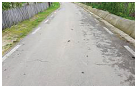
a. fisuri transversale
