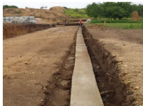
Realizarea fundației unui zid de sprijin din beton versus realizarea fundației unui zid din pământ armat
