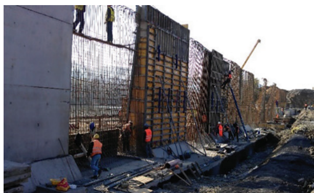
Cofrarea zidului de sprijin din beton versus construcția unui zid de pământ armat
