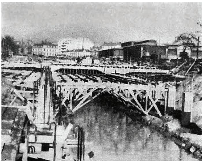
Fig. 9 – Vedere cofragilor și cintrelor
