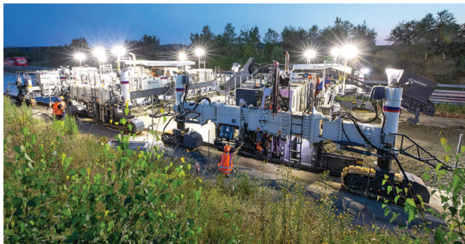
Două finisoare de beton cu cofraje glisante, SP 154 (i) și o mașină de tratare a suprafeței, TCM 180 (i), au fost utilizate ca tren de pozare a betonului pe o porțiune de 67 km din autostrada D1, între Brno și Praga.
