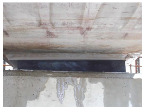
Figura 10, 11 - Aparate montate fără paralelism între fețe
