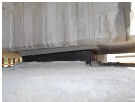
Figura 10, 11 - Aparate montate fără paralelism între fețe
