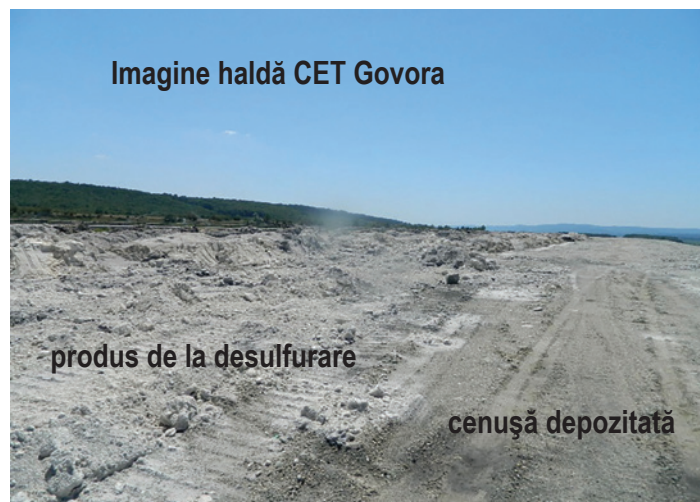
Fig. 1 – Depozit de cenușă și gips sintetic/produs de desulfurare
