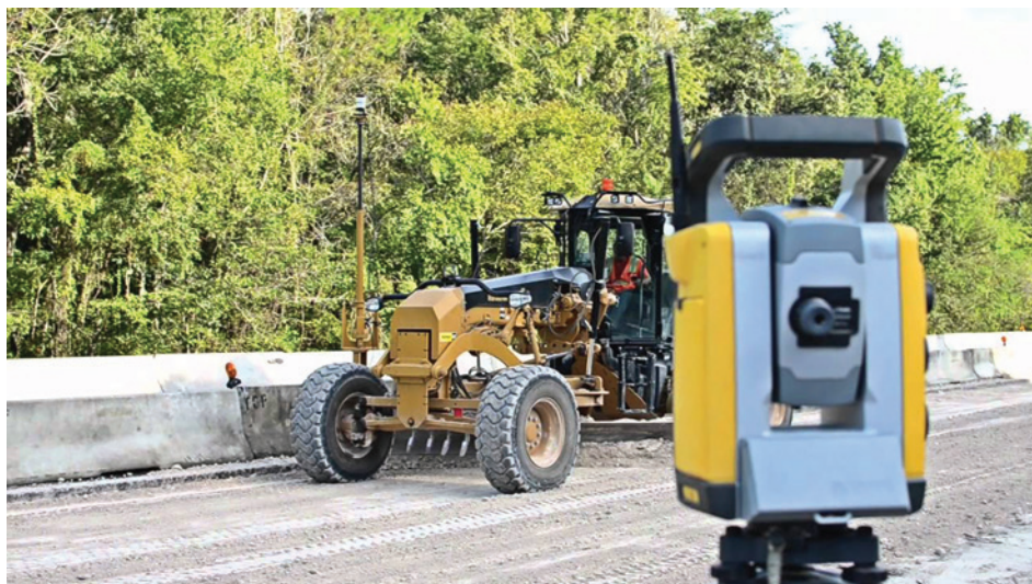
Figura 1 - Sistem de ghidare 3D cu stație totală
