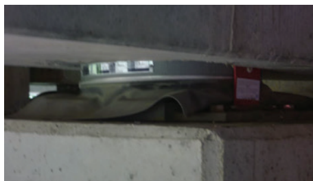
Figura 8 - Aparat montat sub grinda cu placa înglobată deplasată (vedere ansamblu)
