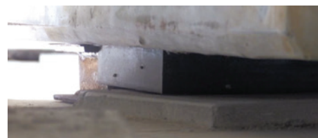
Figura 4 - Aparat de reazem deplasat
