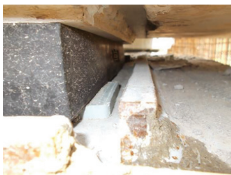
Figura 12 - Introducerea de pene sub aparat / Figura 13 - Aparat dezaxat
