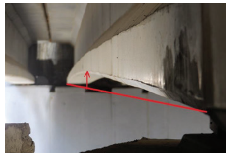
Figura 2 - Contrasăgeata (comparabilă cu grosimea tălpii - 12 cm) generează pante la capetele grinzilor
