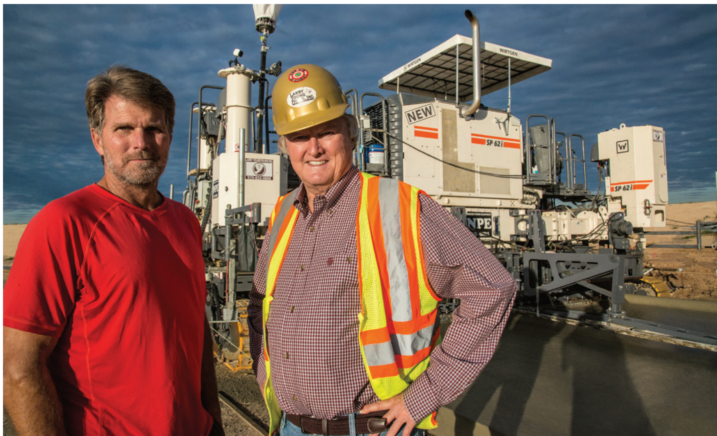
Wallace Phillips, dezvoltatorul proiectului Southern Pointe, și Larry Young, președintele Larry Young Paving Inc, inspectând prima secțiune a drumului
