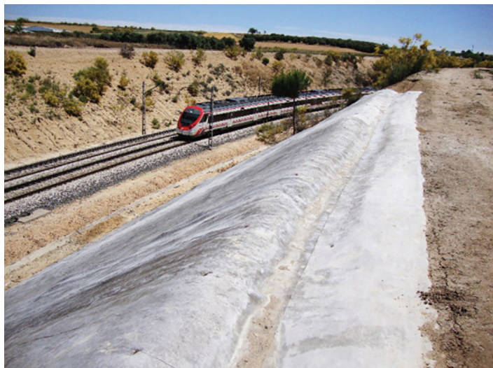
Foto 5 – Impermeabilizare rigolă la partea superioară și control erozional
