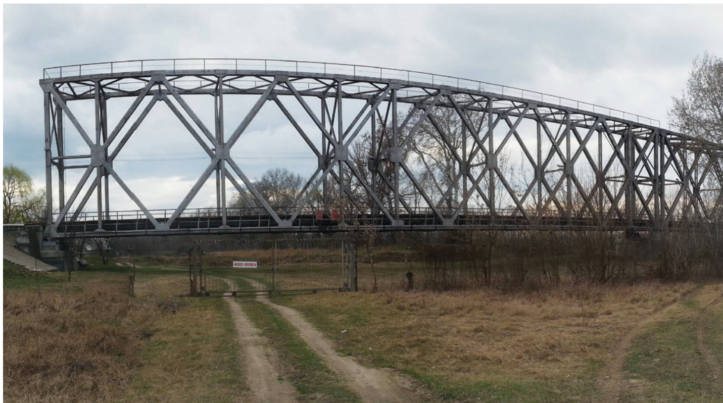
Figura 3 - Podul feroviar de la Ungheni – vedere laterală
