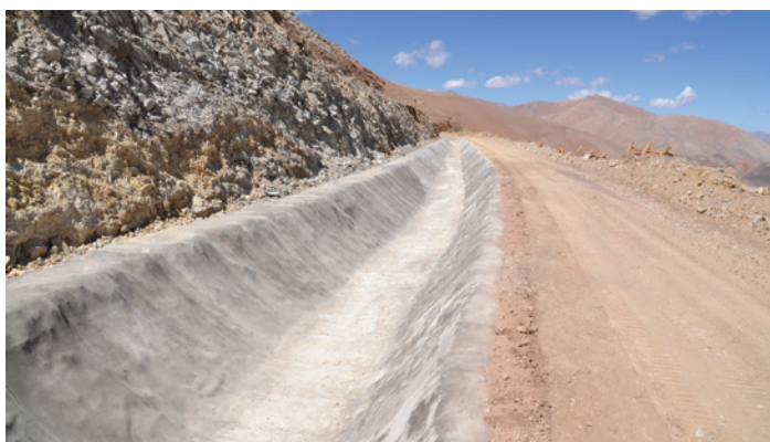
Foto 7 – Impermeabilizare canal
