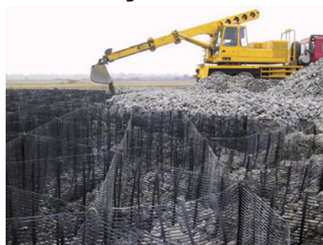
Figura 7 - Tehnologie de umplere geocelule
