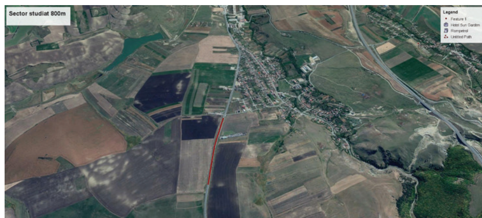
Figura 2 - Sectorul de 800 de metri al DN1, văzut din satelit
