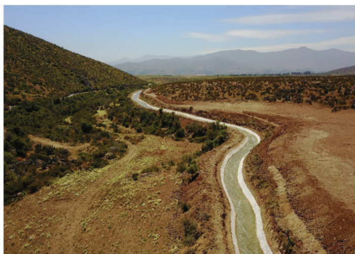
Foto 3 – Una dintre aplicațiile de bază pentru GCCM este impermeabilizarea canalelor
