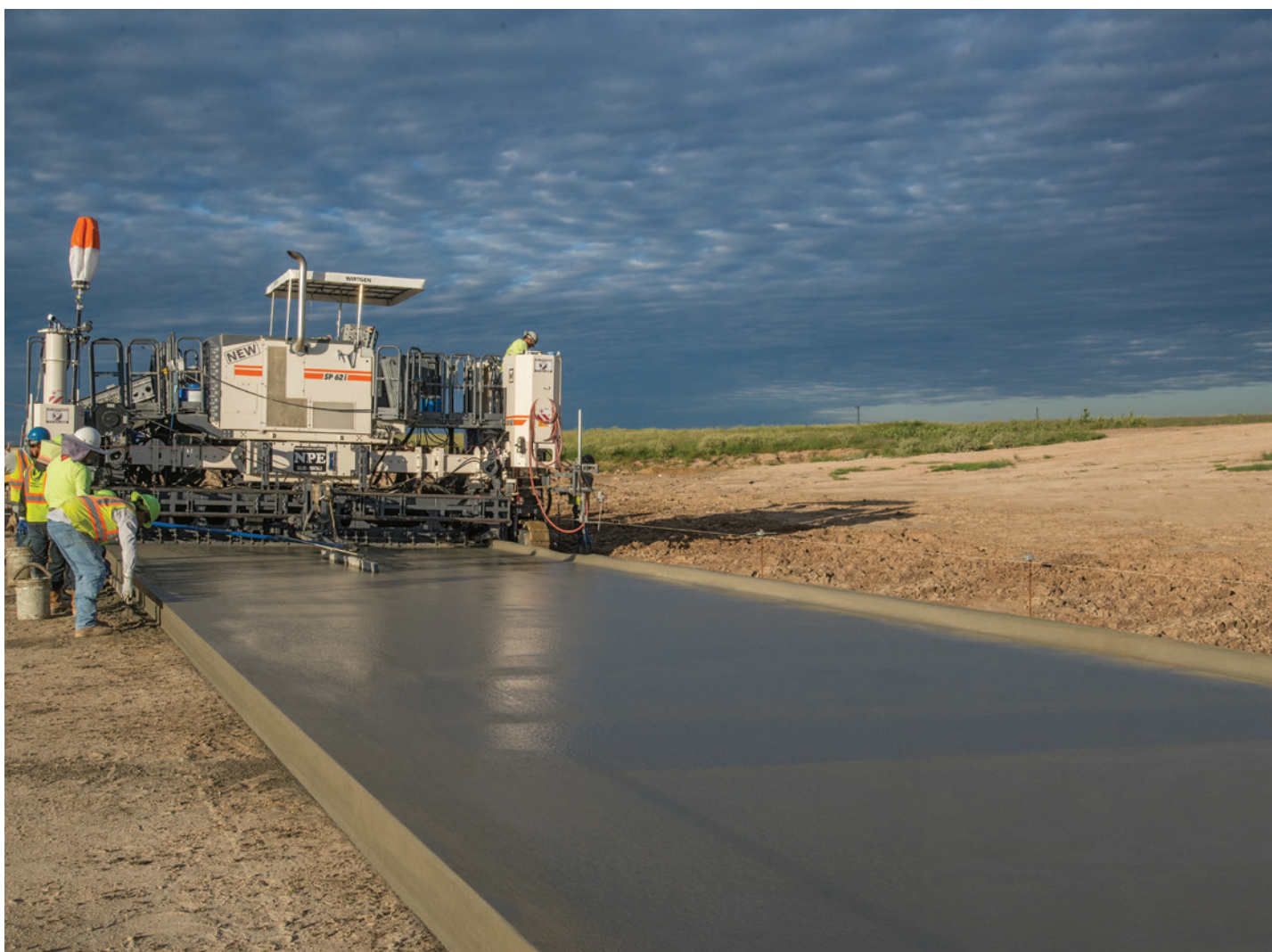
Sistemul inteligent de manevrare și control al finisorului de beton cu cofraj glisant model SP 62i asigură o excelentă manevrabilitate
