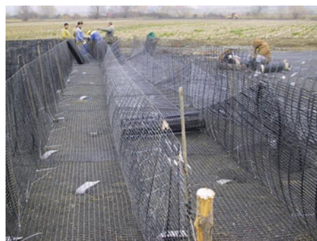
Figura 6 - Tehnologie de realizare geocelule
