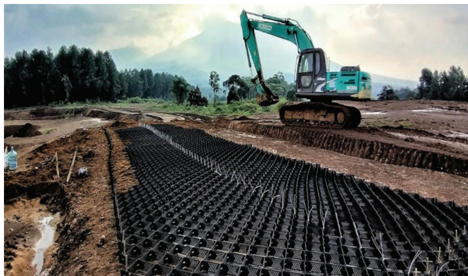
Figura 10 - Aspecte din lucrări în teren
