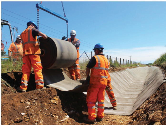
Foto 6 – Impermeabilizare rigole
