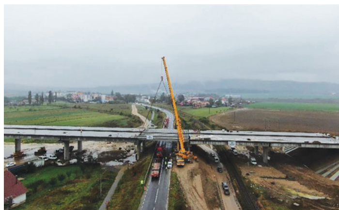
Figura 10 a – Montarea ultimei grinzi
