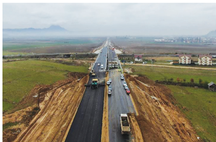
Figura 11 – Asfaltarea stratului de uzură
