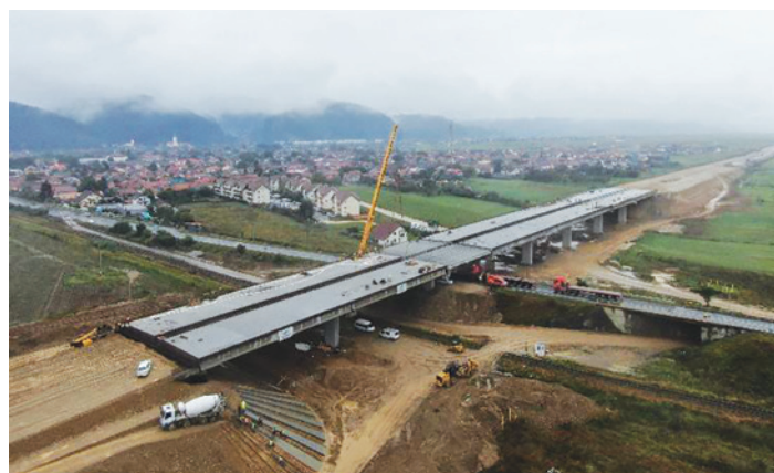
Figura 10 b – Montarea ultimei grinzi
