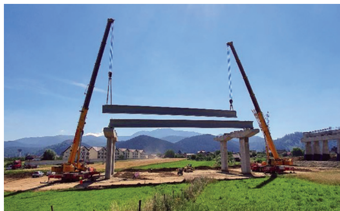
Figura 9 – Montarea primelor grinzi
