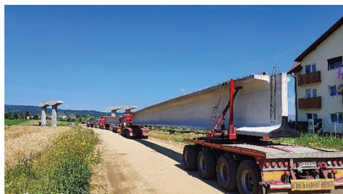
Figura 8 – Transportul agabaritic al grinzilor în șantier
