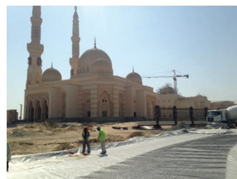
Instalare geogridă hexagonală la drumul din cadrul Ansamblului Rezidențial Baniyas
