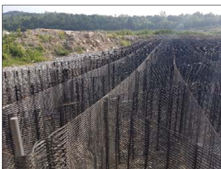
Îmbunătățirea capacității portante a terenului în zona lacului Stejeriș
