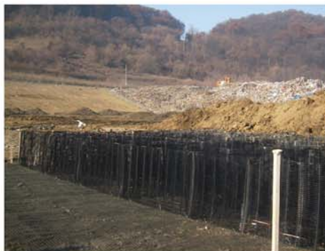
Utilizarea sistemului TensarTech® Stratum® la construirea unui dig la depozitele de deșeururi în condiții de teren foarte moale (Sighișoara, România).
