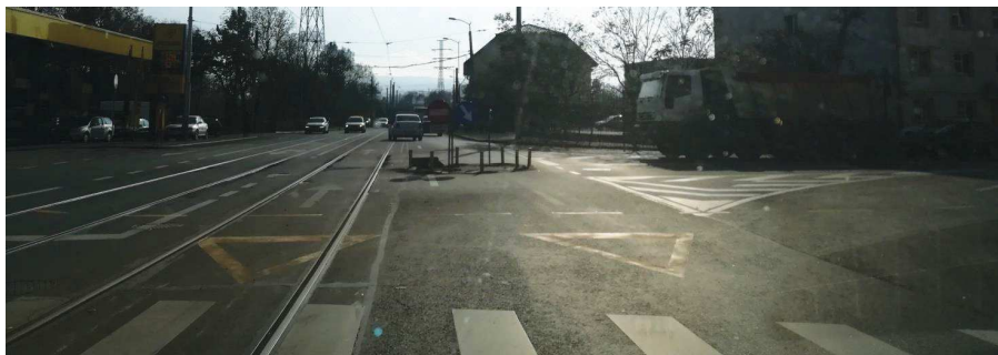
Figura 2 – Intersecția giratorie de la intersecția străzilor Oașului cu Gării. Principalele puncte slabe ale intersecției sunt poziția și diametrul insulei centrale.
