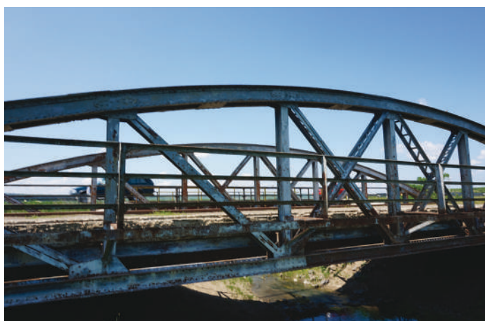
Vedere laterală a Podului Crasna
