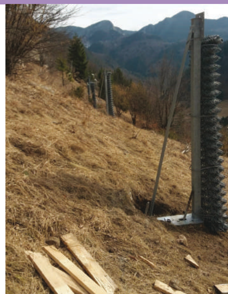
Foto 2 - Instalare stâlpi de barieră
