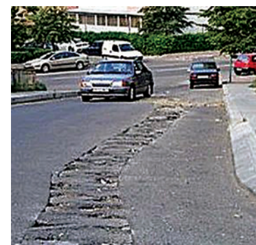
Figura 19 c - Refacere defectuoasă a infrastructurii rutiere după intervenții la utilități
