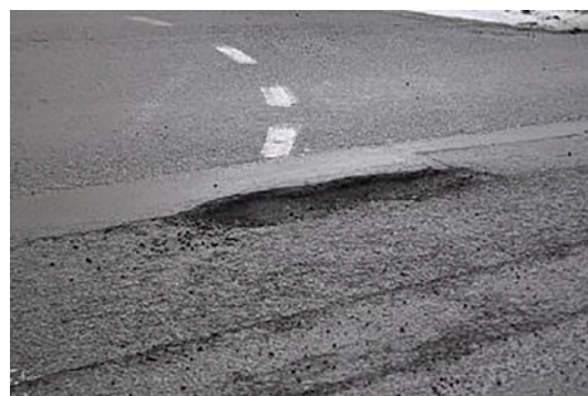
Figura 18 b - Rostul de lucru neetanș este originea dezvoltării gropilor adiacente plombelor
