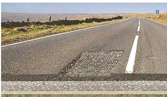
Figura 11 - Frezare zonă defectă
