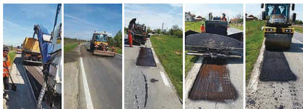
Figura 9 - Utilaje necesare tehnologiei clasice
