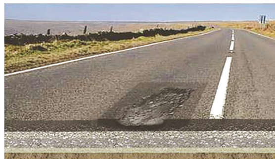
Figura 12 - Încălzire zona defectă
