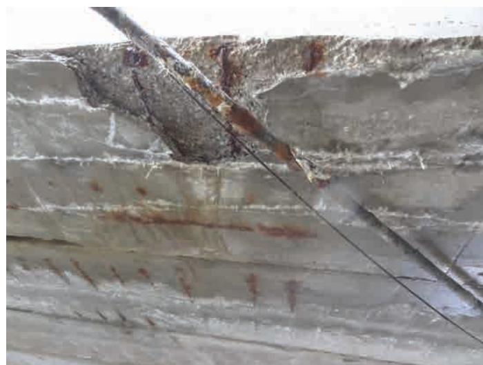
Fig. 1. Străpungerea hidroizolației a permis infiltrarea apei între fâșiile cu goluri, iar ulterior în interiorul fâșiilor cu goluri, expertiza recomandând înlocuirea suprastructurii.
