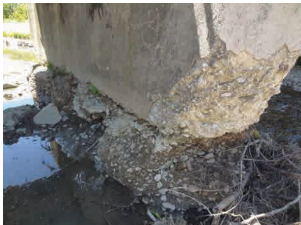
Fig. 2. Utilizarea unor betoane de clasă inferioară a avut ca rezultat degradarea elementelor respective, expertiza recomandând înlocuirea infrastructurii (Bc10=C8/10).
