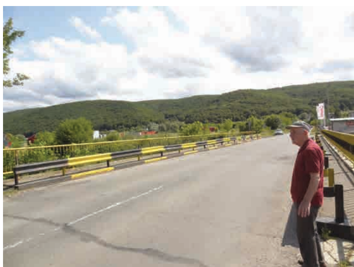
Fig. 7. Pod pe drumul județean DJ 103K, peste râul Nadăș în Căpuș, hidroizolat cu Hidroizoflex în anul 2002.
