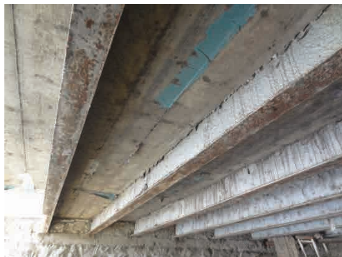
Fig. 6. Intradosul suprastructurii de pe Str. Oțetului nu prezintă infiltrații după 18 ani.
