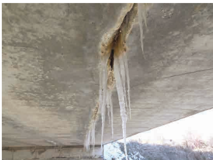
Fig. 1. Străpungerea hidroizolației a permis infiltrarea apei între fâșiile cu goluri, iar ulterior în interiorul fâșiilor cu goluri, expertiza recomandând înlocuirea suprastructurii.
