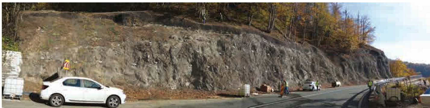
Foto 2: - Poziția 5, sistemul Tecco® G65/3 realizează un contact intim cu suprafața neregulată
