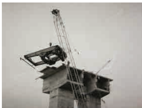
Montarea cărucioarelor de ridicare și susținere a tronsoanelor
