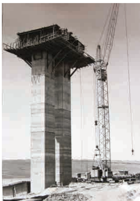
Schela de susținere cofraj amorsă Cofrarea tronsonului amorsă din beton turnat pe loc
