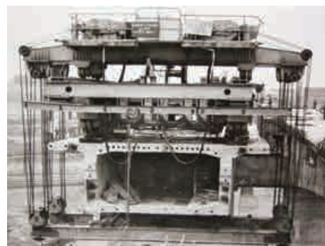
Instalația de ridicare și susținere a tronsoanelor
