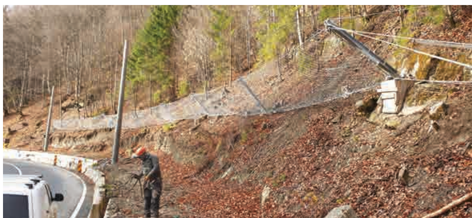
Foto 4: - Poziția 6, bariera GBE-500A instalată
