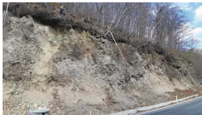
Foto 1: – Selecție taluzuri cu urme de instabilități de suprafață
