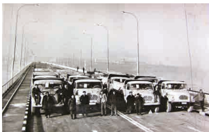
Amplasarea camioanelor (2) simetric pe ambele casete
