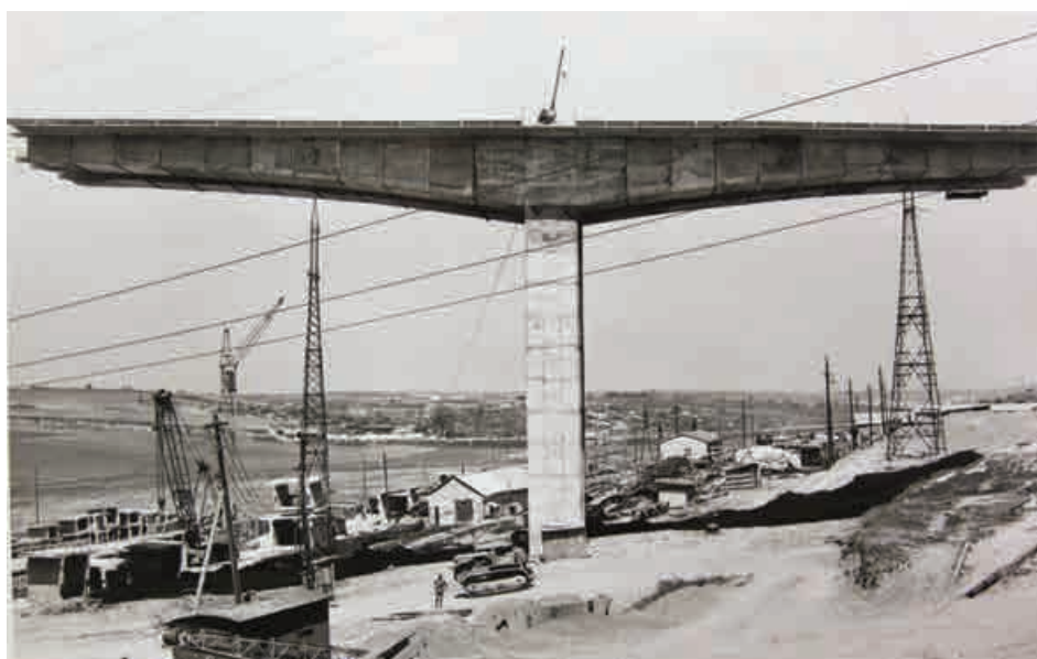
Pilă la care asamblarea tronsoanelor a fost încheiată
