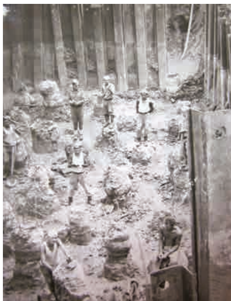
Lucrări la incinta de palplanșe pentru pregătirea capetelor piloților
