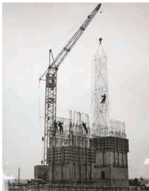
Armarea și cofrarea pilelor. S-au folosit cofraje cățărătoare și cofraje glisante.
