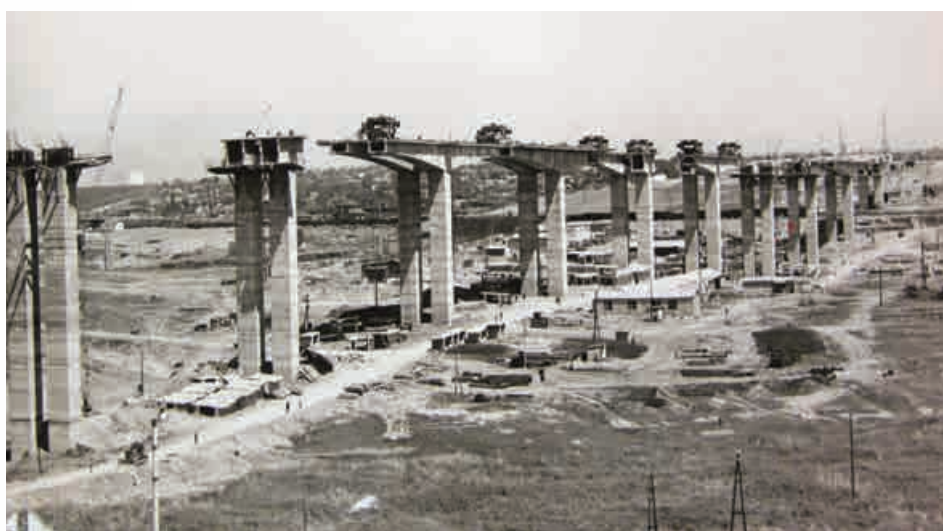
Faze de execuție a viaductului
