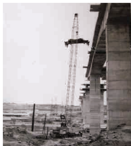
Coborârea instalației de ridicare-susținere a tronsoanelor
