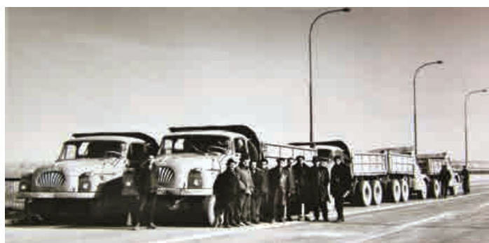
Amplasarea camioanelor (1) asimetric pe o singură casetă
