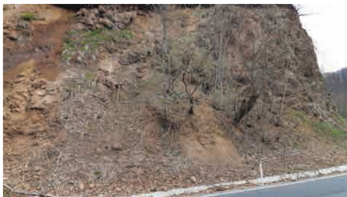
Foto 1: – Selecție taluzuri cu urme de instabilități de suprafață
