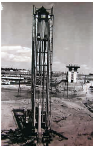
Soneta KPF-22 cu care s-au executat 1.670 piloți Franki
