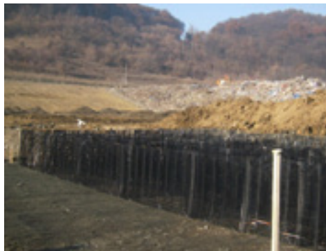
Utilizarea sistemului TensarTech® Stratum® la construirea unui dig la depozitele de deșeurii în condiții de teren foarte moale (Sighișoara, România).
