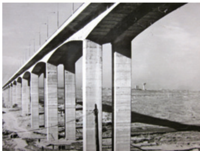
Vedere parțială de jos a viaductului
