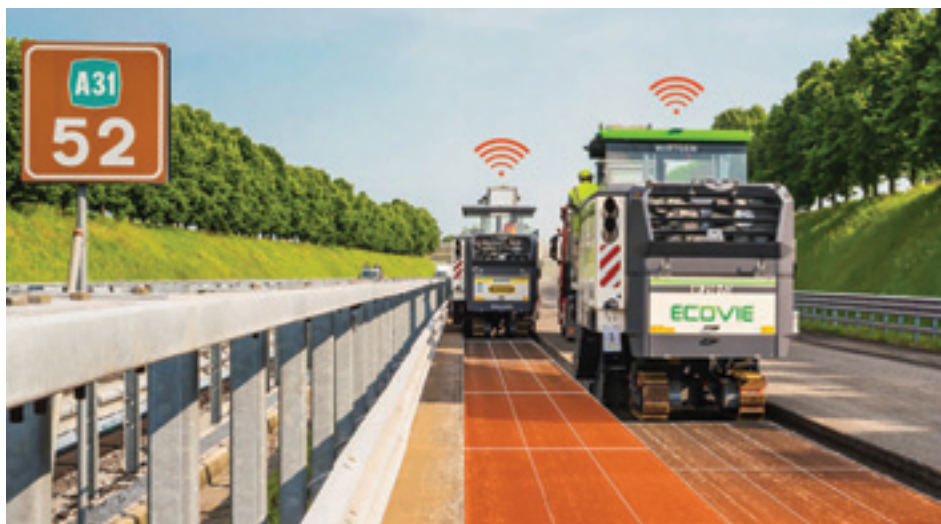
Foto 3 – Cu noul sistem PERFORMANCE TRACKER (WPT), Wirtgen a dezvoltat o soluție inovativă care, pentru prima dată, face posibilă documentarea precisă și fiabilă a lucrărilor efective de frezare realizate.
