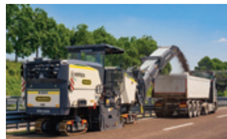
Foto 2 – W 210 Fi, mașină profesională cu un randament de frezare excepțional, își demonstrează potențialul deplin pe Autostrada A31 din nordul Italiei.
