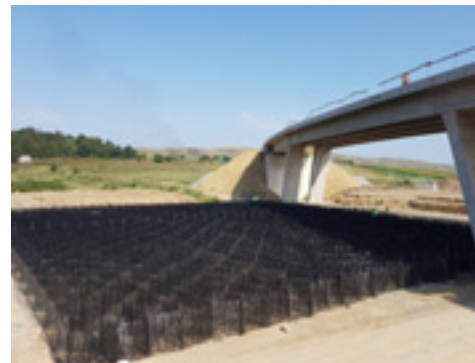
Utilizarea sistemului TensarTech® Stratum® cu controlul tasării diferențiate (Autostrada Sebeș - Turda, România).
