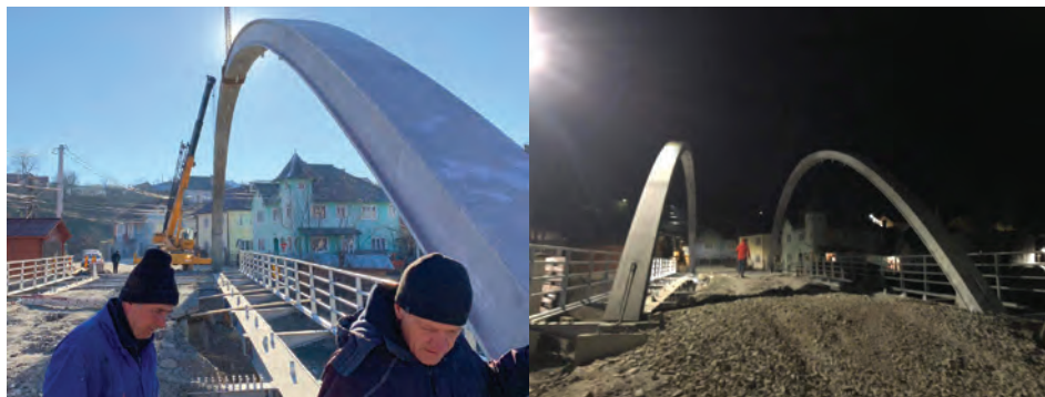
Fig. 10 Montajul arcelor metalice
