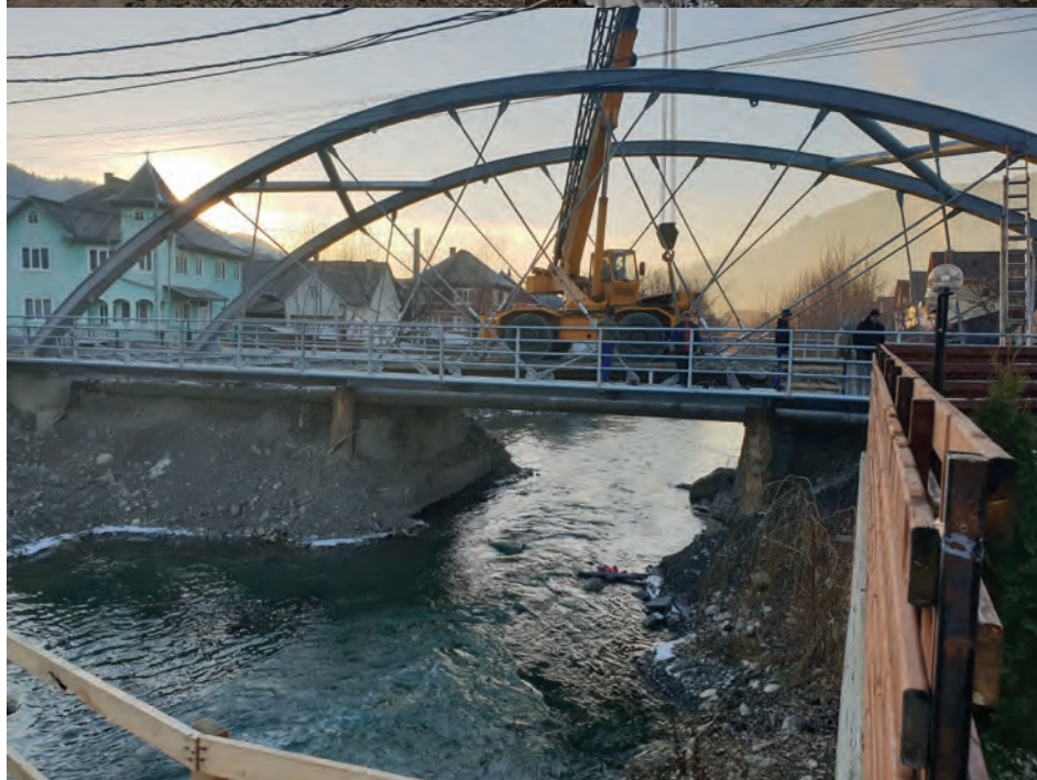
Fig. 11 Montajul contravântuirilor și a tiranților
