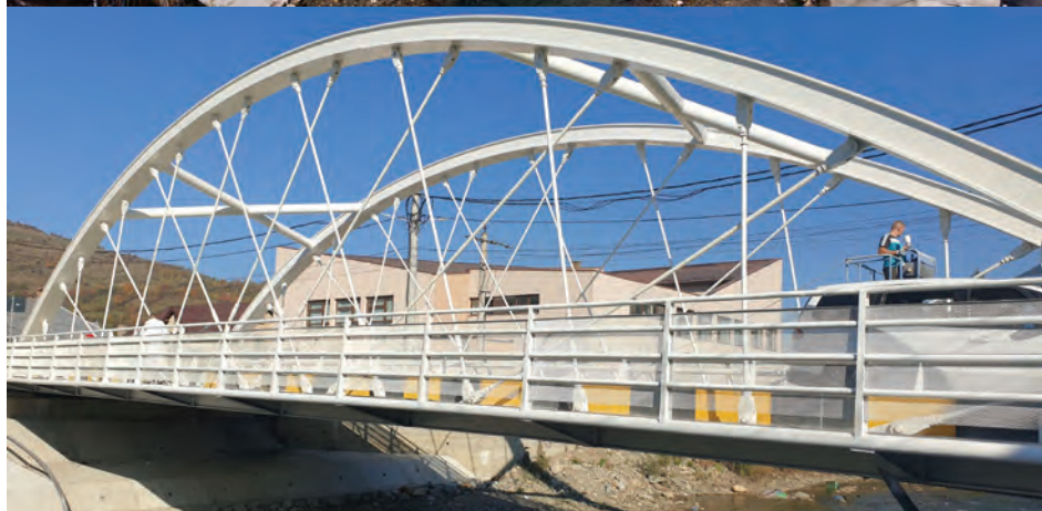
Fig. 14 Pregătirea recepției la terminarea lucrărilor
