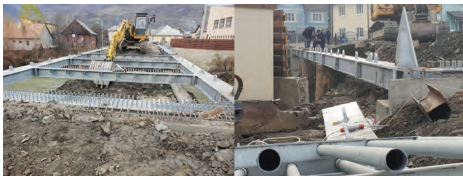
Fig. 9 Montajul grinzilor tirant și a antretoazelor
