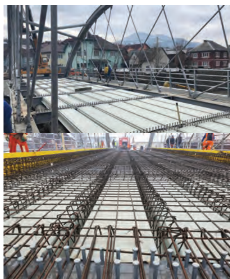
Fig. 12 Montajul cofrajelor colaborante și a armăturii în placă
