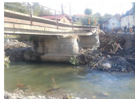
Fig. 7 Desfacerea parțială a podului existent și execuția fundațiilor
