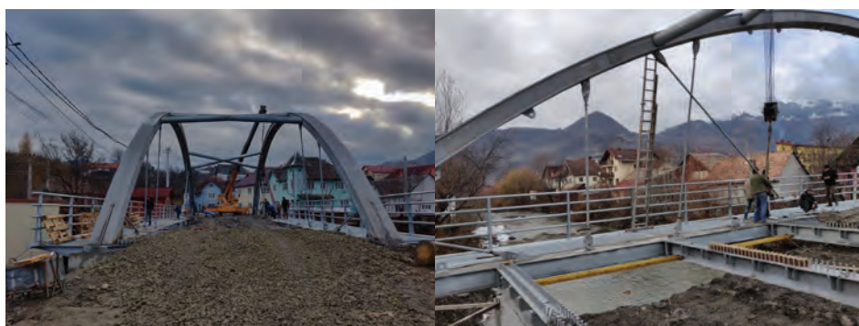
Fig. 10 Montajul arcelor metalice
