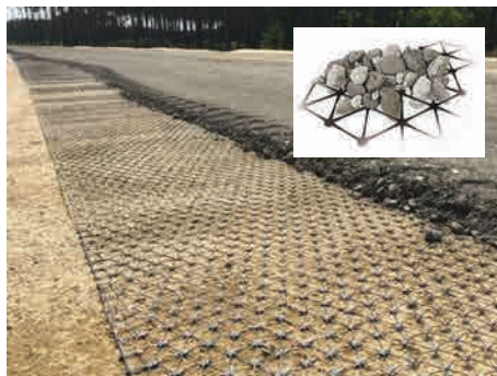
TriAx® instalat la Centura ocolitoare Rzepin
