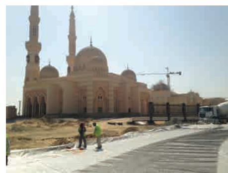
Instalare geogrilă hexagonală la drumul din cadrul Ansamblului Rezidențial Baniyas
