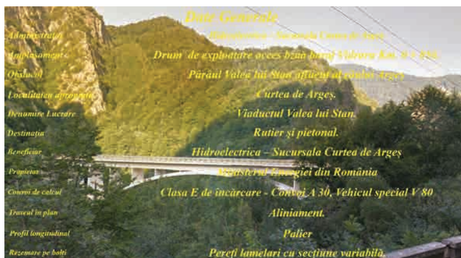
Fig. 4.9. Saltul căprioarei. Elevația amonte a viaductului Valea lui Stan văzută de pe drumul Transfăgărășan DN 7C
