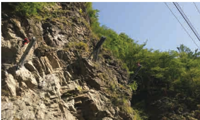
Foto 2: Instalarea cablurilor superioare
