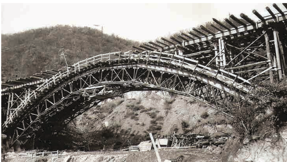
Fig. 1.0.7. – Cintrul metalic din elemente de inventar utilizat la execuția bolții flexibile. Fotografie din anul 1967, colecția ing. Constantin Safta.
