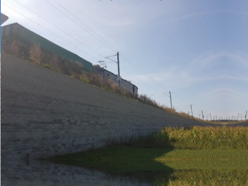
Structură de sprijin CF Vințu de Jos
