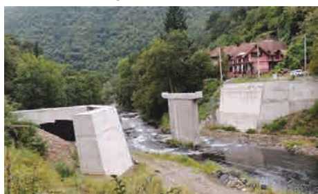
Figura 6 – Vedere laterală amonte
