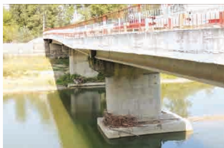
Figura 2 - Vedere laterală amonte
