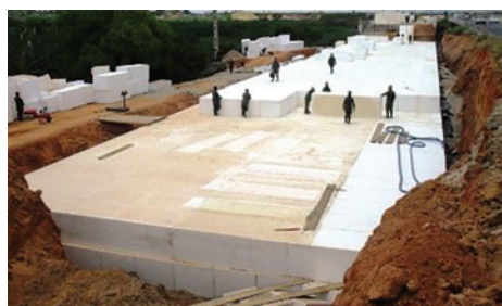
Figura 12 – Înlocuirea terenului slab de fundare cu geospume (www.eldia.com.bo)
