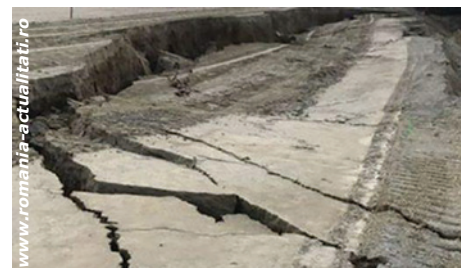
Figura 6 – Surparea terasamentului la Autostrada Lugoj - Deva
