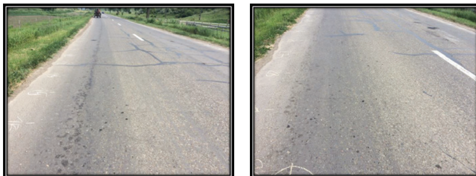
Figura 6 – Fotografii, de pe sectorul studiat, cu degradări de tip suprafață șlefuită
