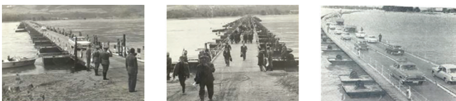
Poduri peste Dunăre întinse de Regimentele 2 și 72 Pontonieri: Porțile de Fier (1964) și Giurgeni (1969)
