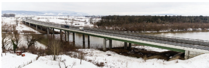
Fig. 13 - Pod peste Mureș pe Varianta de Ocolire a Devei
