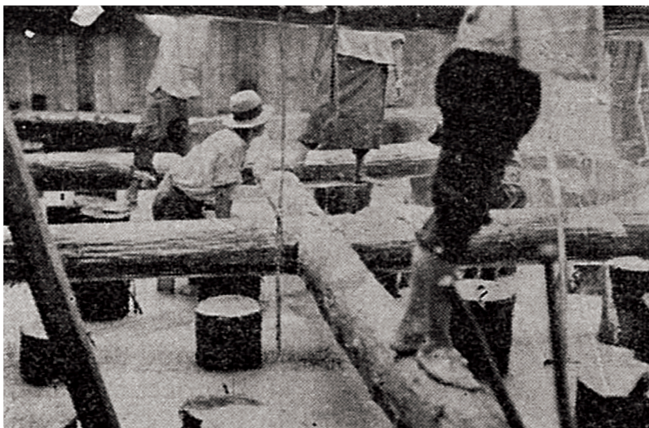
Fig 6 - Podul Ineu. Retezarea piloților la 50 cm de la cota fundațiilor.
