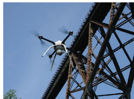
Figura 9 – Scanarea podurilor prin intermediul dronelor
