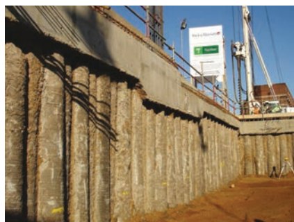
Perete din piloți forăți distanțați
