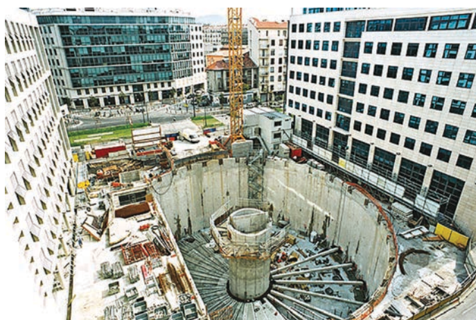
Sprijinire tip incintă din pereți îngropați
