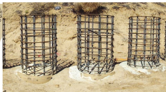
Sprijinire din piloți forăți secanți
