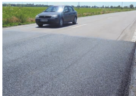
Figura 5 - Așternerea covorului asfaltic fonoabsorbant pe DN 2B km 106
