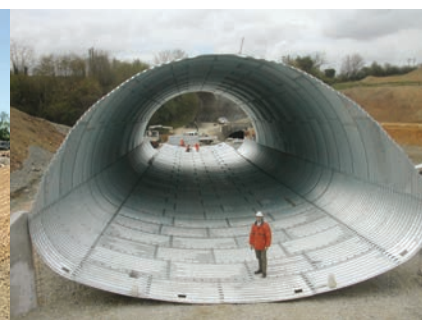
Structura din tablă ondulată, înainte de punerea în operă
