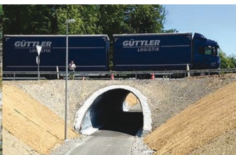
Structuri de sprijin hibride, din tablă ondulată
