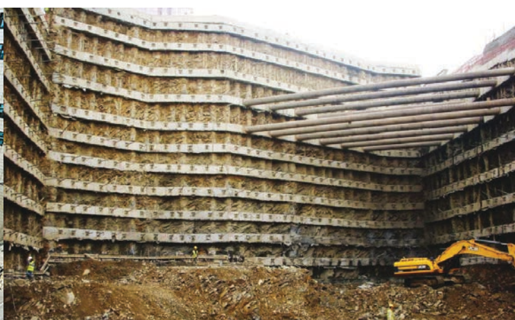
Sprijinire din piloți forăți distanțați și ancorați
