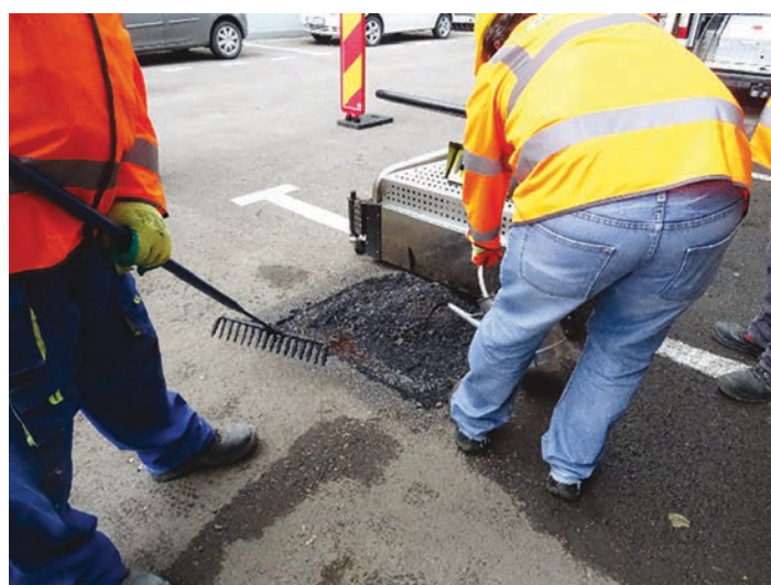
Foto 6: Au fost adăugate două lopeți de mixtură stocabilă încălzită în buncărul autoutilitarei
