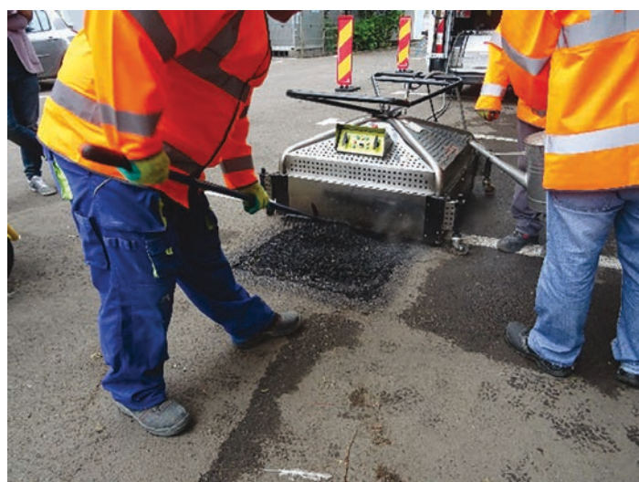
Foto 7: Se nivelează suprafața cu grebla
