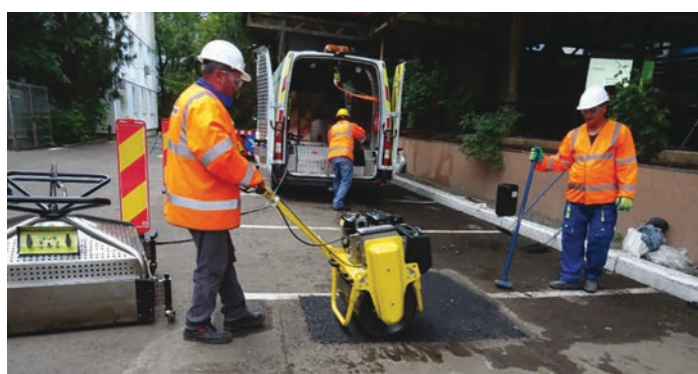
Foto 14: În finalul prezentării a fost extinsă suprafața reformată fiind prelucrați 3 mp. În imagine se execută compactarea celei de-a treia suprafețe
