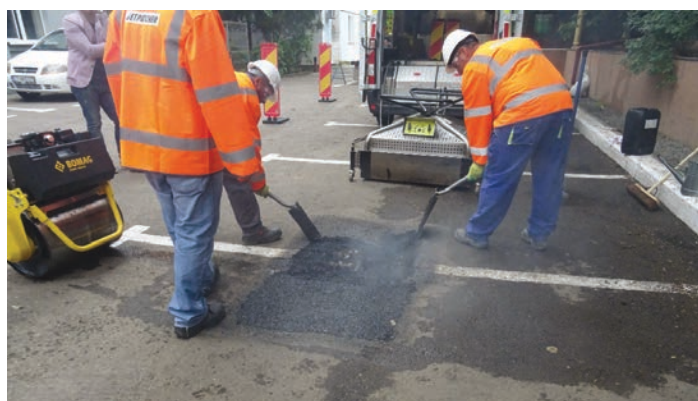
Foto 11: Se scarifică a doua suprafață
