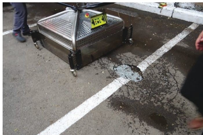
Foto 1: Suprafața degradată care urmează a fi reparată
