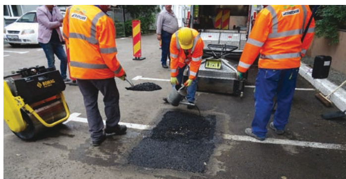
Foto 12: Se adaugă câteva lopeți cu mixtura stocabilă încălzită în buncărul autoutilitarelor precum și emulsie bituminoasă pentru reținerea liantului
