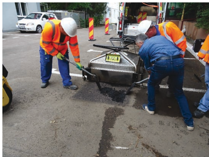
Foto 5: Cu cazmaua și grebla se scarifică suprafața încălzită. Pe contur se lasă o fâșie de 7 – 10 cm nescarificată pentru asigurarea legăturii calde cu amestecul de mixtură scarificată + aportul de mixtură stocabilă
