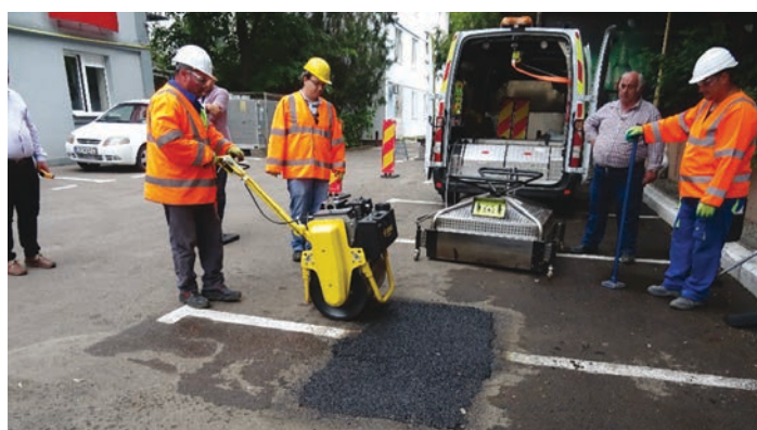
Foto 13: Se compactează a doua suprafață reformată
