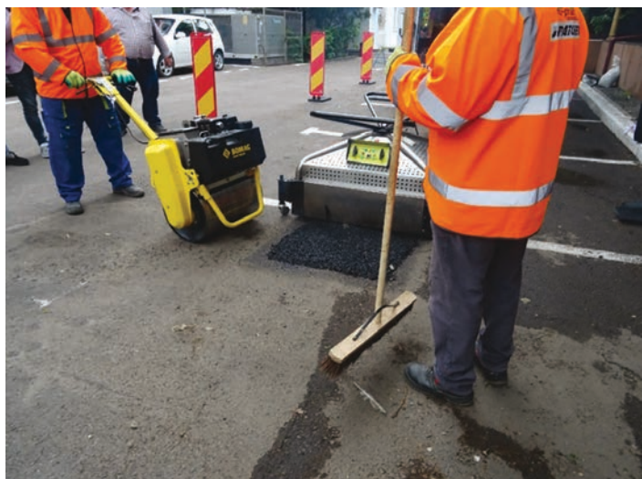
Foto 8: Se compactează suprafața cu cilindrul lis
