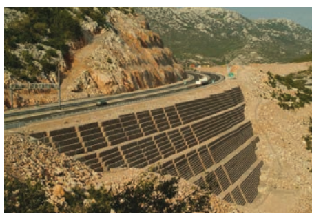
Figura 4 – Structuri de sprijin din gabioane și din căsoaie
