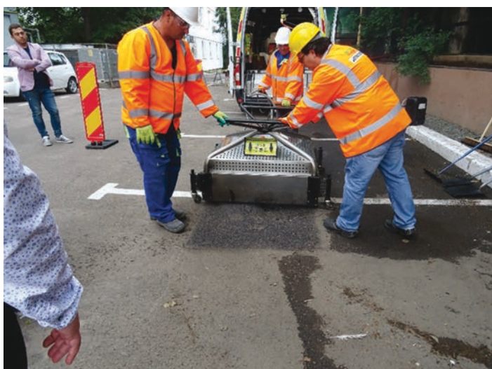
Foto 4: S-a terminat încălzirea suprafeței (zona gri) iar panoul radiant este mutat pentru a încălzi zona adiacentă care trebuie reparată
