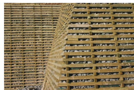
Figura 4 – Structuri de sprijin din gabioane și din căsoaie
