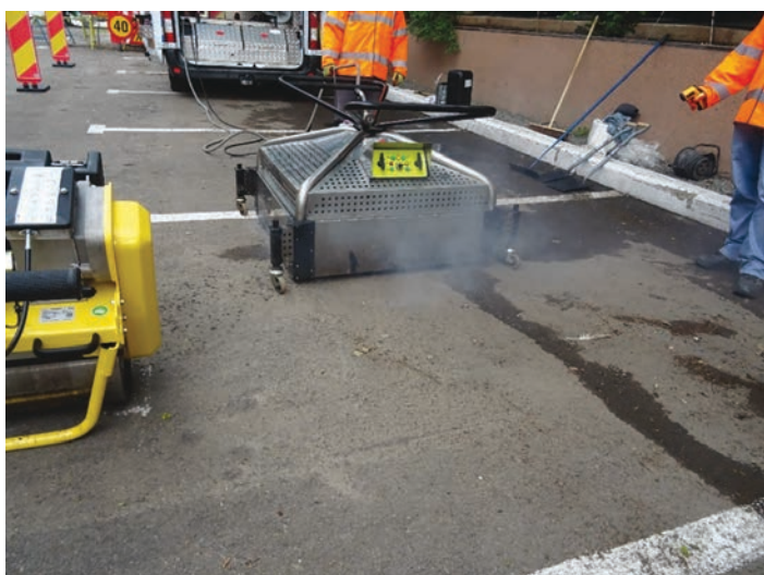
Foto 3: A început încălzirea suprafeței. Iese abur din cauză că suprafața era udă
