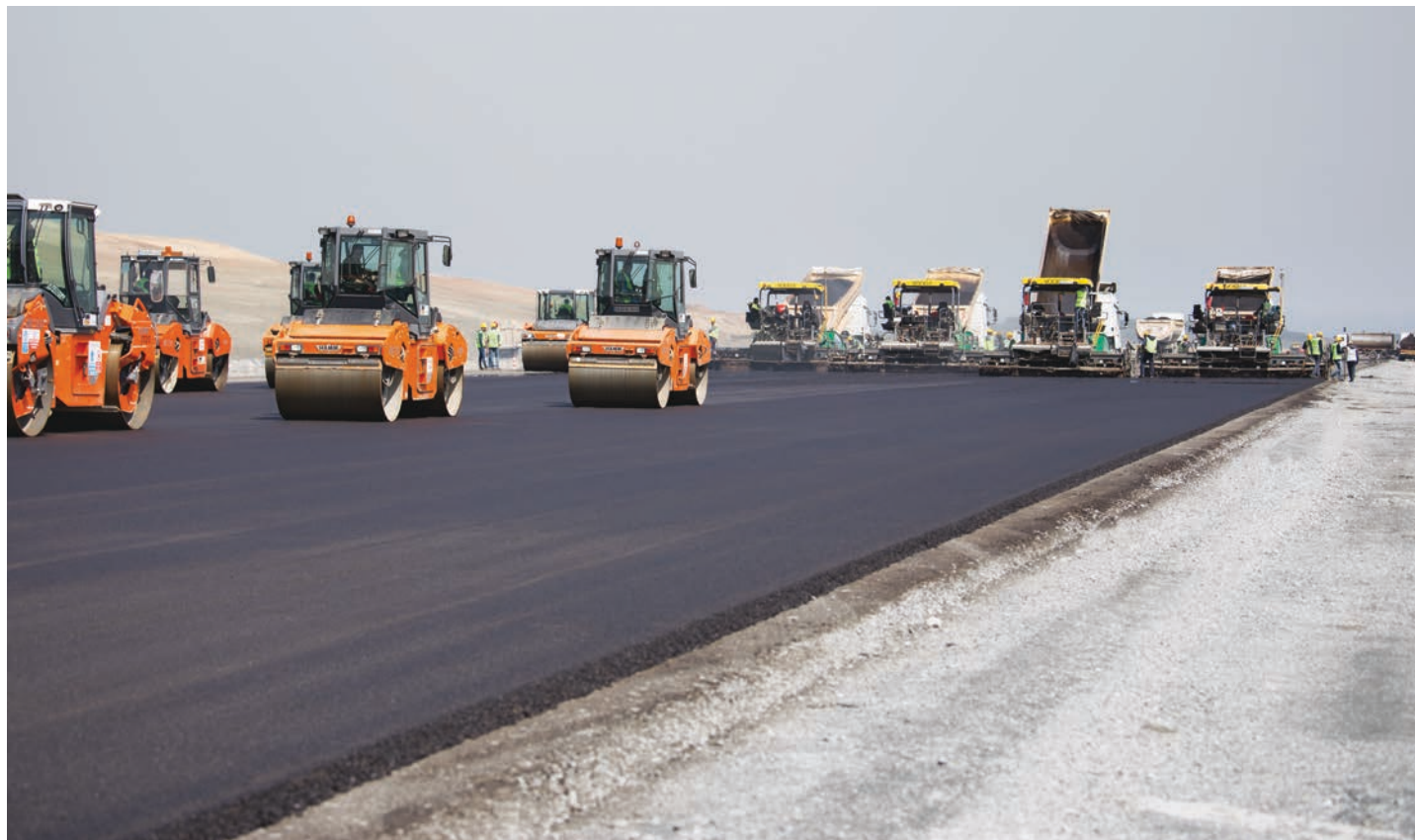
Nu mai puțin de 12 finisoare Vögele au lucrat intens, așternând asfaltul pentru piste și drumurile de acces colaterale
