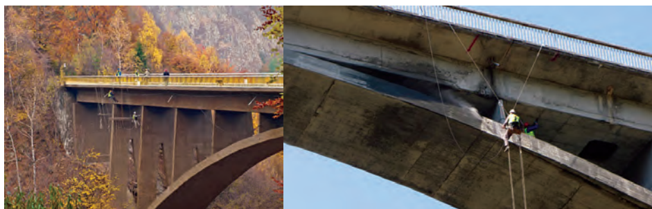
Fig. 7 Aspecte de la repararea structurii de rezistență cu betoane speciale
