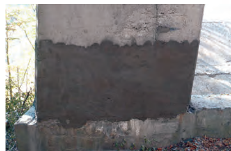
Fig. 11 Zonă degradată după consolidare
