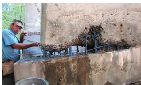
Fig. 8 Bare de armătură protejate prin vopsire
