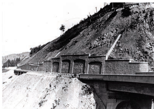
Cleionaje cu prefabricate „japoneze”
