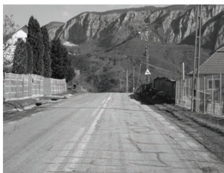
Fig. 4 Vizibilitate în profil longitudinal: situații necorespunzătoare
