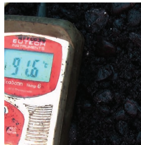
Foto 5 Warm mixt asphalt (Asfalt mixt cald)
