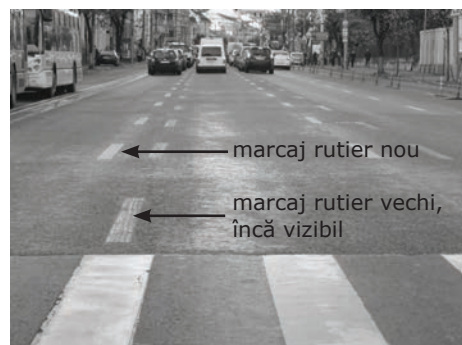
Fig. 7 Marcaje rutiere necorespunzătoare
