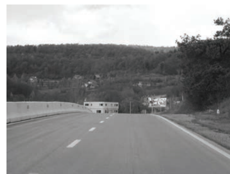
Fig. 4 Vizibilitate în profil longitudinal: situații necorespunzătoare
