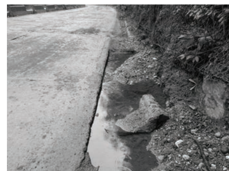
Fig. 9 Colectarea, scurgerea și evacuarea necorespunzătoare a apelor pluviale
