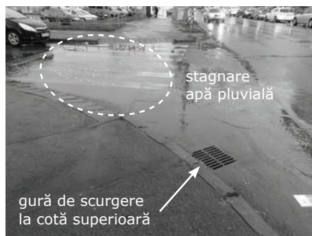
Fig. 9 Colectarea, scurgerea și evacuarea necorespunzătoare a apelor pluviale
