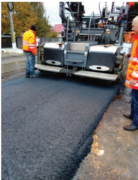
Echipa de DRDP Iași toarnă covor asfaltic pe DN 15D cu prima șarjă de asfalt
