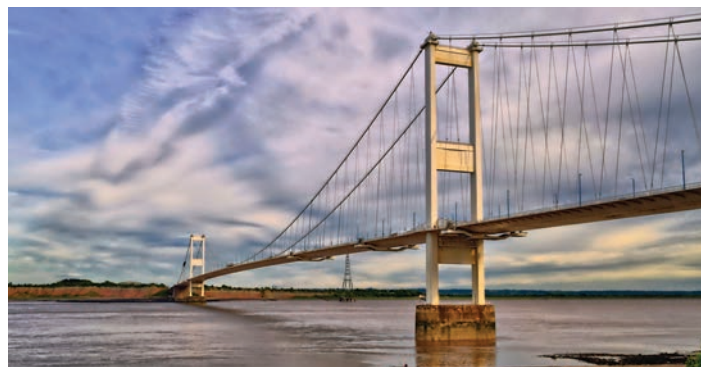
Figura 52 - podul Severn, de lângă Bristol
