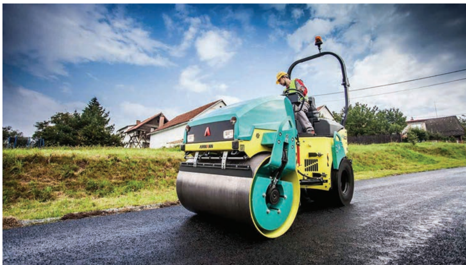
Compactare prin vibrație
