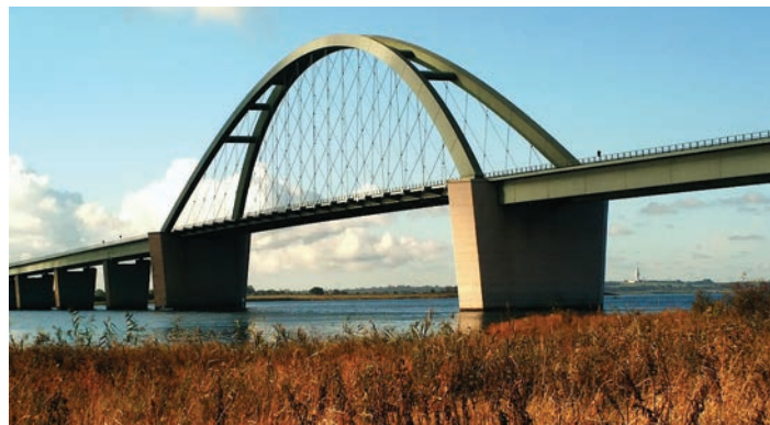
Figura 49 - podul Fehmarnsund, între RFG și Danemarca
