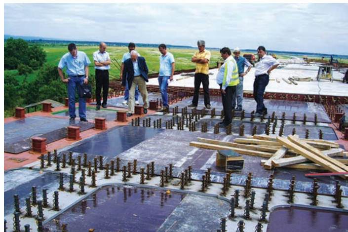
În vizită de lucru pe șantier, împreună cu proiectanții (persoana cu pălărie)
