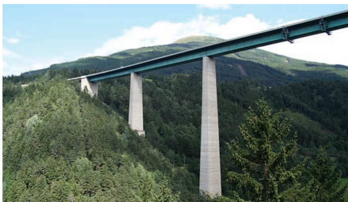
Figura 39 - viaductul Europa peste Valea Sill, lângă Innsbruck
