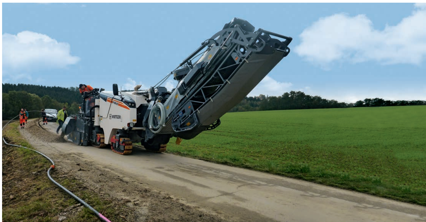
Pentru lucrările de drumuri locale, furnizorul de servicii de frezare folosește W 100 CFi, un model ce face parte din cea mai nouă generație de mașini de frezare compacte.
