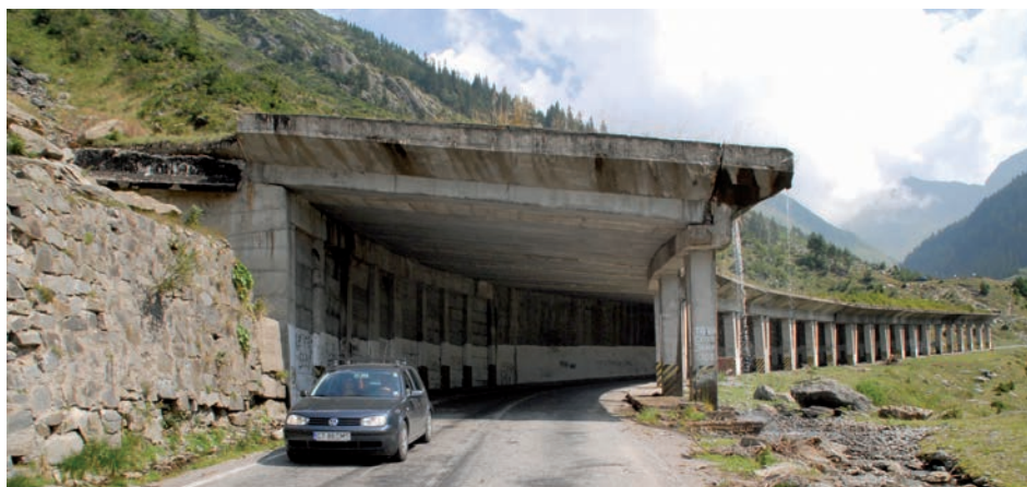
Copertinele de protecție - frumoase lucrări de artă
