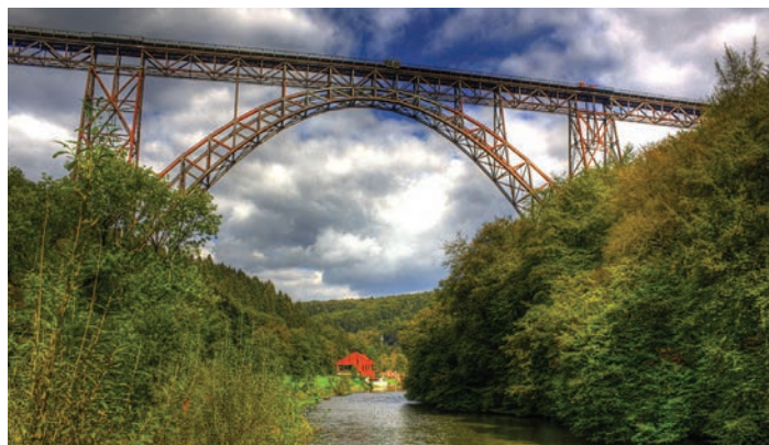
Figura 30 - viaductul de cale ferată peste Valea Fupper, la Müngsten, în Germania
