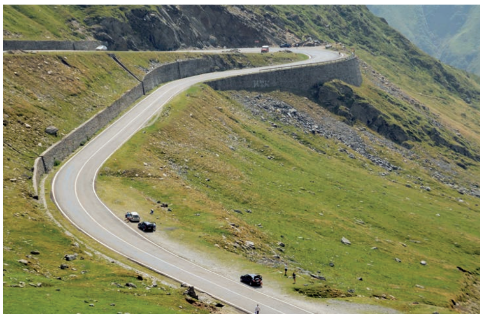
Zidurile de sprijin depășesc 8.000 m
