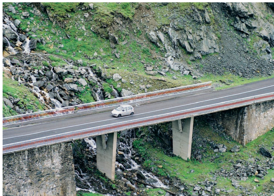
Viaduct în zona de nord a Transfăgărășanului
