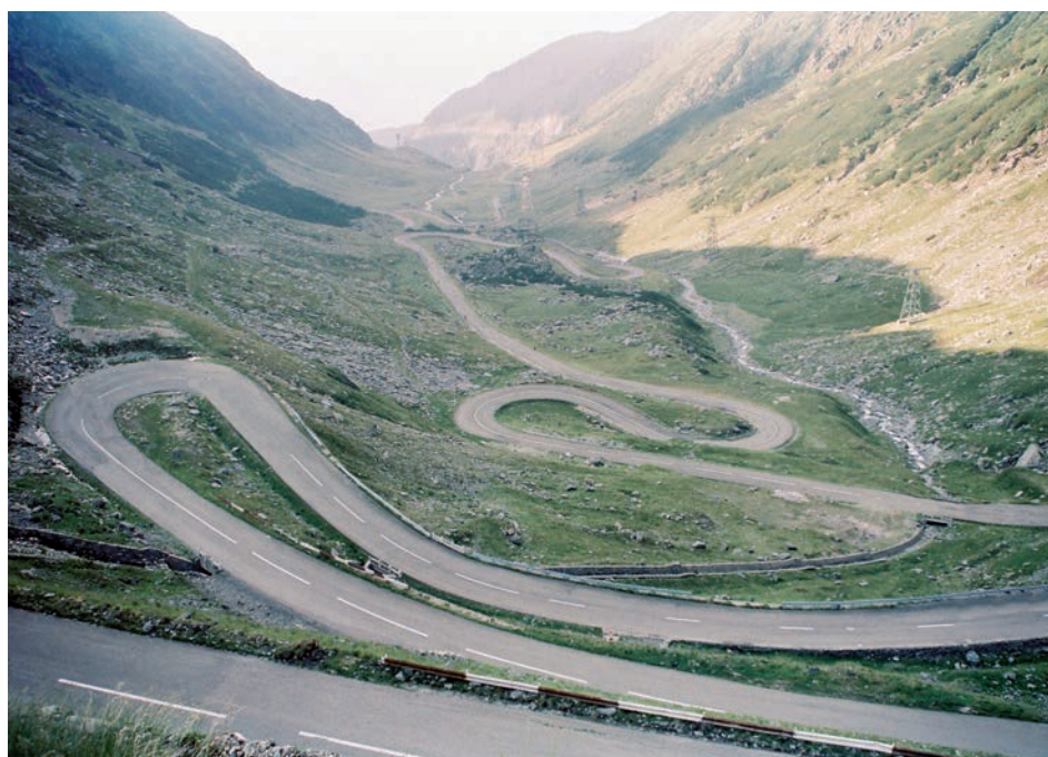
Zona de nord a Transfăgărășanului
