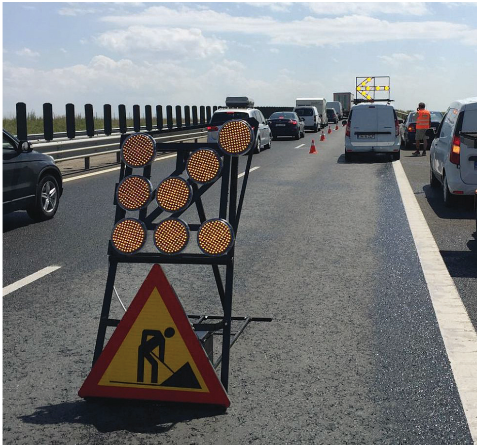
Panouri efectuate în regie proprie de către DRDP Timișoara, pe A1
