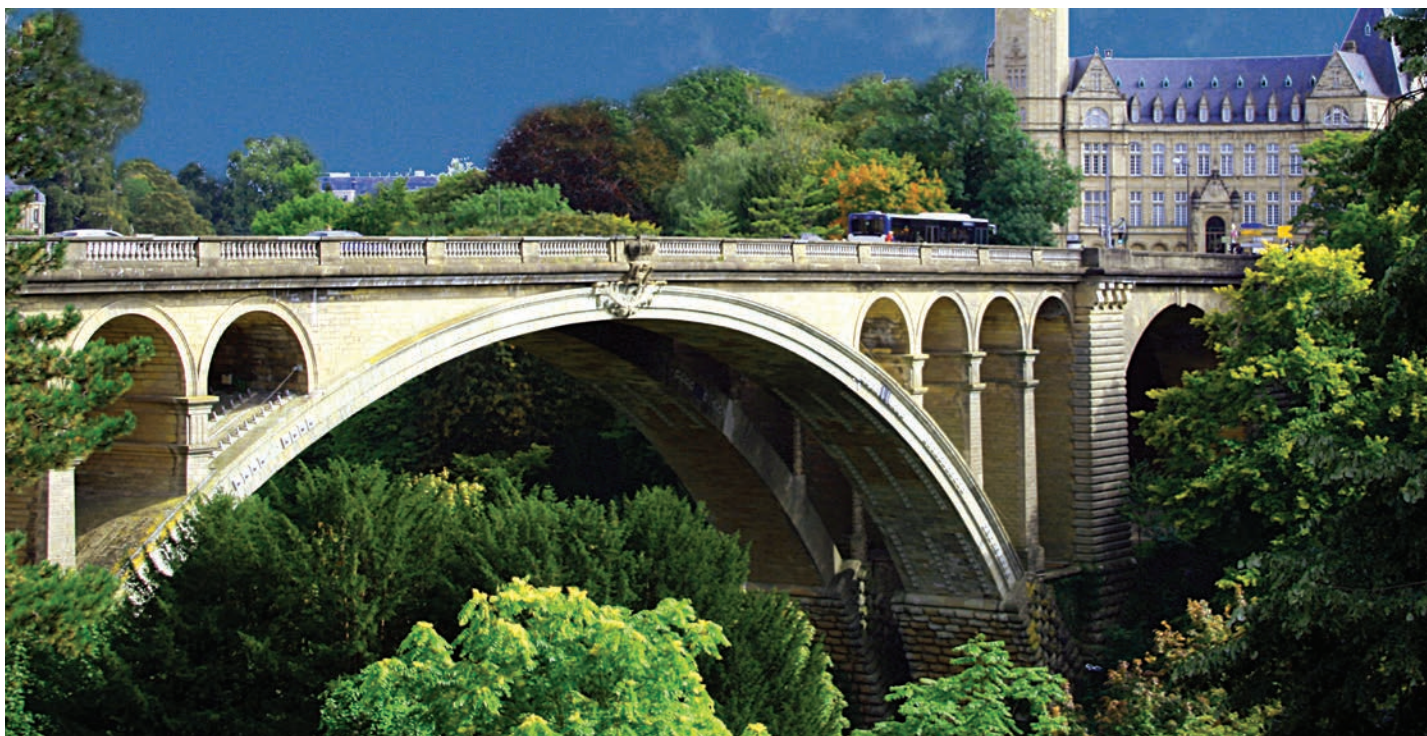
Figura 17 Viaductul Luxemburg. (foto: internet - Claude Wians)
