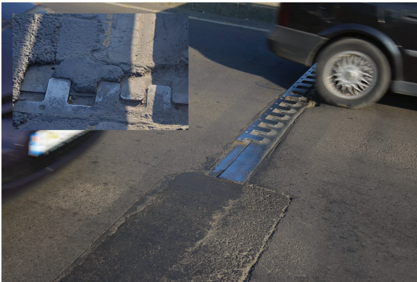
“Pasajul Grant” – mixtura asfaltică peste rosturile metalice: o soluție tehnică tipică... “bucureșteană”!
