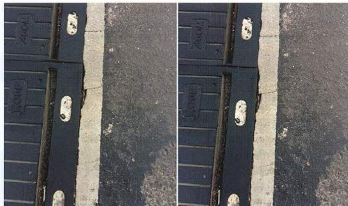
Figura 1 - Îmbinările dintre rigolele metalice și beton
