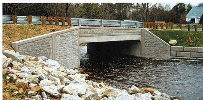
**Fig. 5 - Podeț dalat, la sud de Dunăre, construit cu racorduri din zidărie de piatră**
