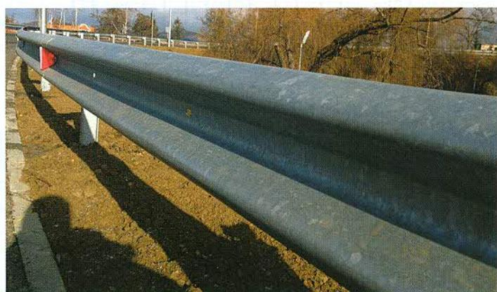
zarea parapetelor, acestea se realizează conform proiectelor tip. Pentru produsele realizate în conformitate cu SREN 1317, este necesar testul de impact [2], [3], [4], [5].
