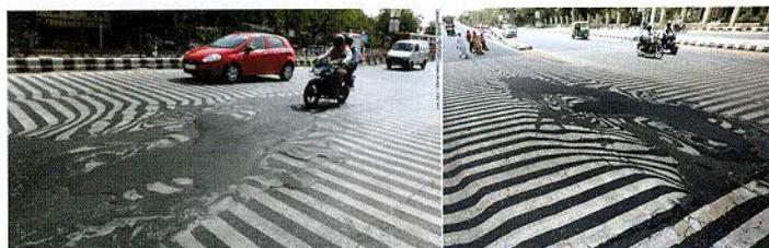
**Figura 5 - Degradări datorate temperaturilor ridicate, pe străzi din India**
