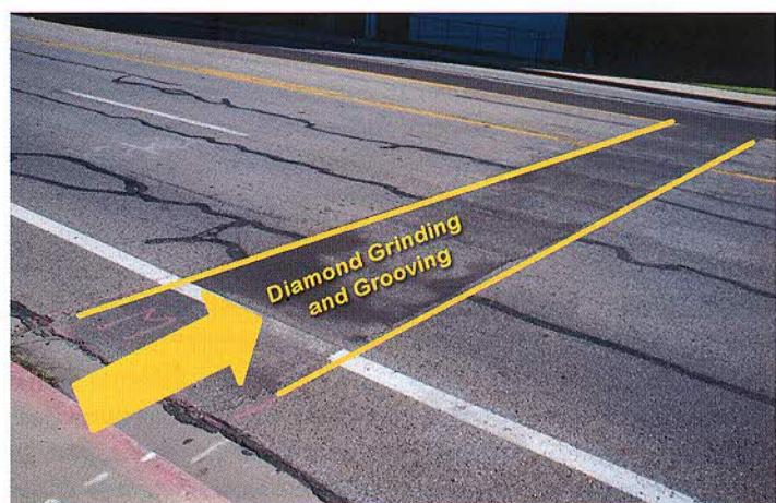
finețe care poate fi utilizat, specificațiile și echipamentele care să evaluate datele și deciziile tehnice ce trebuie luate. Vom aminti doar că uniformizarea unei căi de rulare se face, de regulă, pe baza: indicelui internațional de planeitate (IRI) și a celui profilograf (PRI). Modul în care cei doi indici și derivatele lor sunt utilizați diferă însă de la caz la caz, de la țară la țară, în funcție de cerințele de evaluare impuse.
