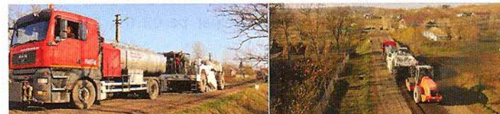
**Fig. 6 - Procesul de reciclare a straturilor asfaltice efectuat pe drumul D.J. 282**
