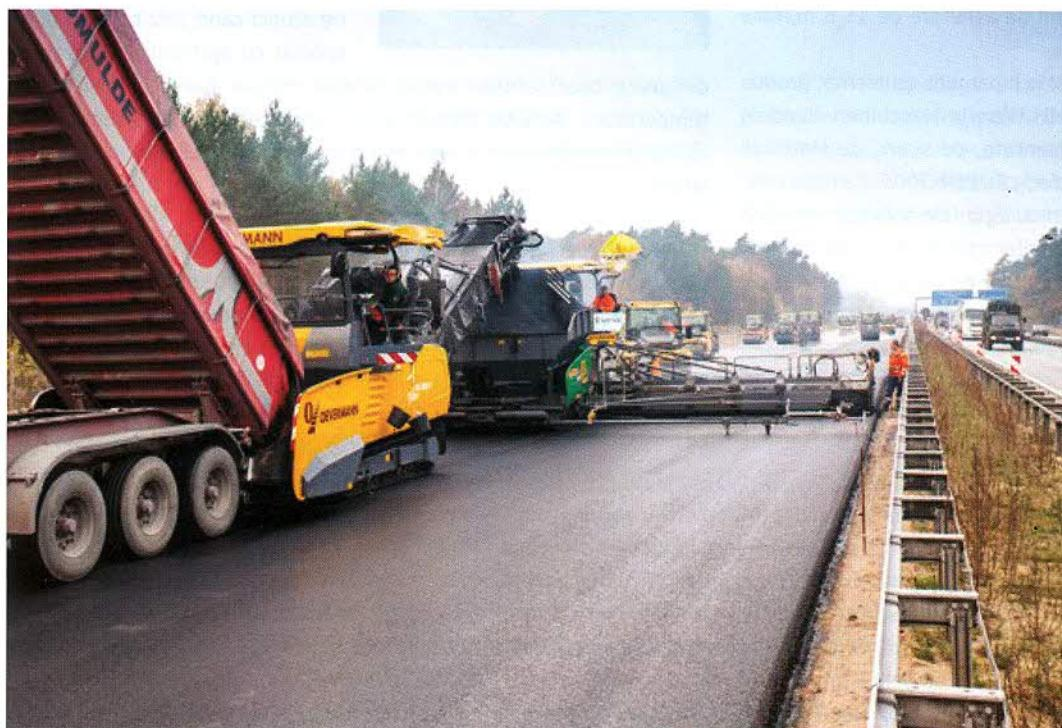
importantă cerință tehnică pentru transferul fără contact al materialului către finisor. „VÖGELE PowerFeeder” a fost echipat cu un sistem de trei senzori individuali cu laser, localizați în partea inferioară a transportorului pivotant. Acest lucru asigură faptul că distanța dintre buncărul de alimentare și finisor rămâne constantă, chiar și atunci când unul sau mai mulți senzori sunt acoperiți din greșeală. Aceștia nu doar previn
