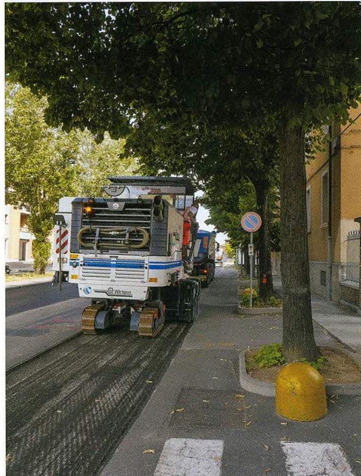
*Frezarea rapidă a unor suprafețe mari, cu precizie milimetrică, a fost doar una dintre numeroasele provocări întâmpinate în Modena. Freza „Wirtgen W200 Hi” i-a impresionat pe toți cu productivitatea sa.*
