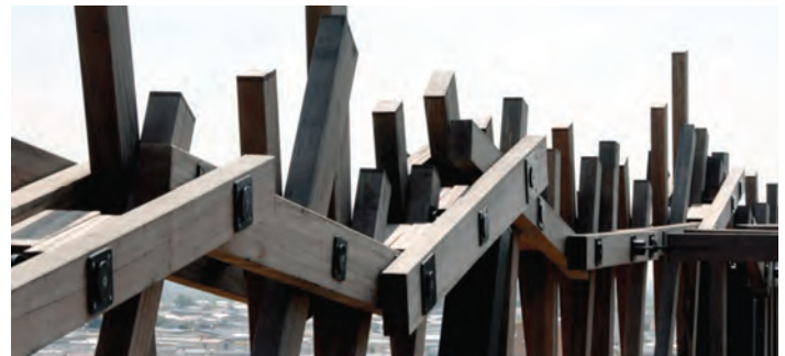
Fig. 4 – Detalii de prindere în noduri
