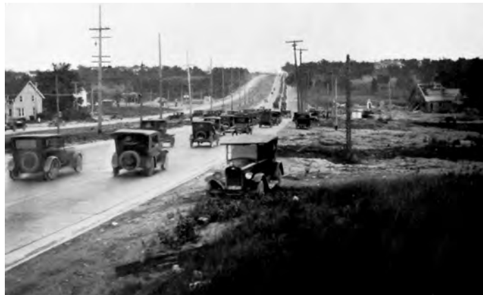
Primii kilometri de drum din beton din lume (1926, Woodward Avenue, S.U.A.)
