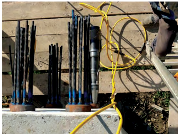
Foto 7 – Precomprimare transversală
