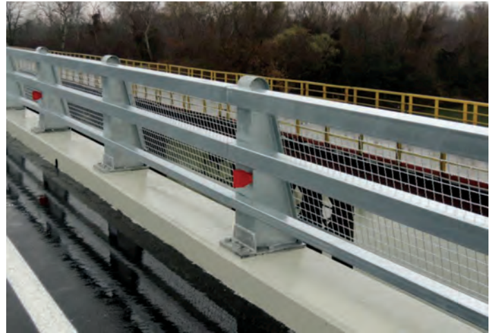
Foto 12 – Parapet la pod fără trotuar
