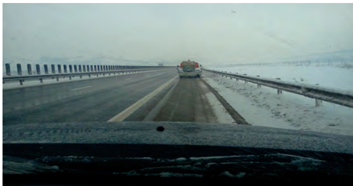
Figura 8. Acționare cu soluția „Atica TZ-1”, 1.000 l, prin cădere în jet continuu
