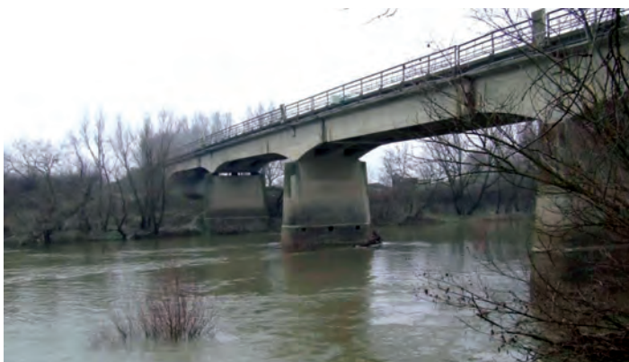
Foto 1 - Vedere din aval
