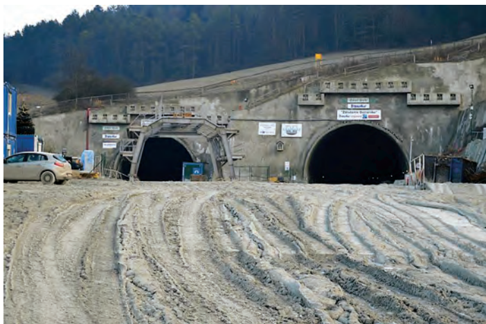
Ovcarsko, un tunel de 2,367 km, finalizat în proporție de 50%
