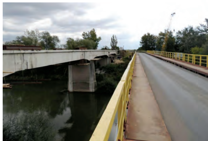
Foto 10 – Pod provizoriu - în exploatare
