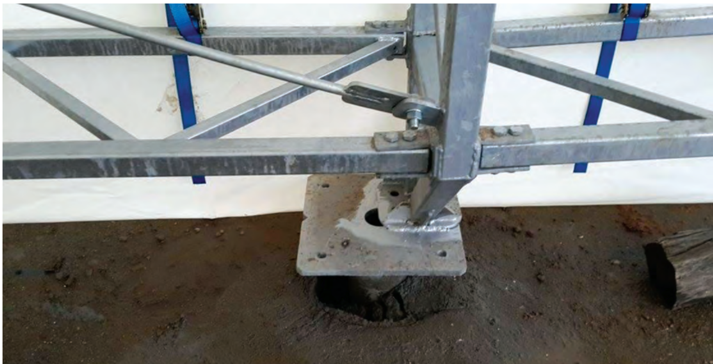
Fig.5. Ancorarea la sol
