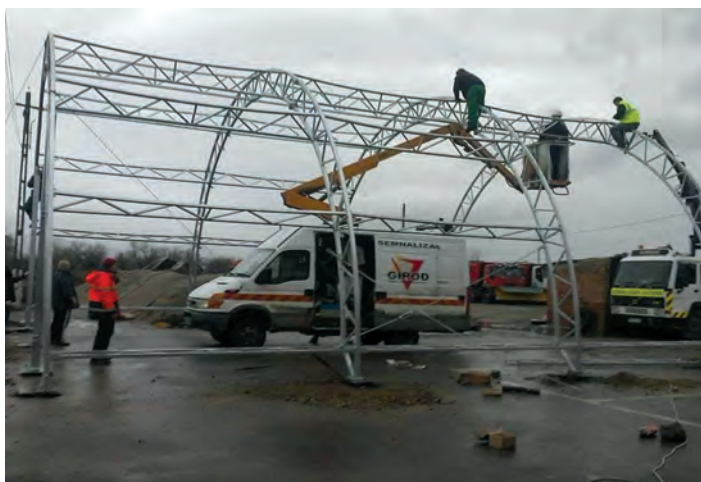
Fig.7. Rigidizarea cadrelor de grinzi cu zăbrele
