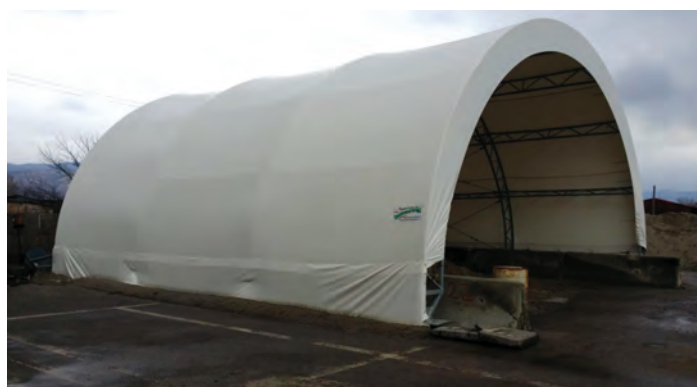
Fig.11. Soclu de beton
