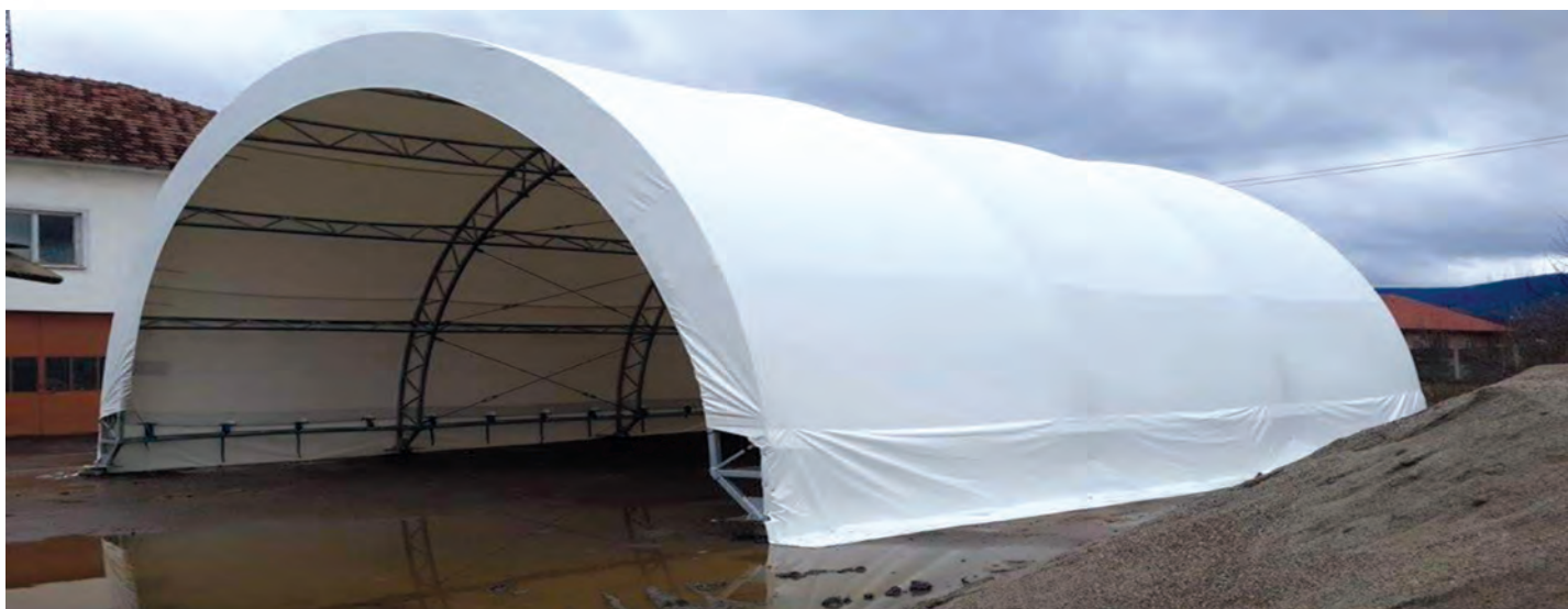
Fig.10. Prelata tensionată peste structura metalică
